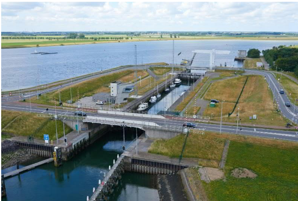
Figuur 1 De Zandkreeksluis in de Zandkreekdam
