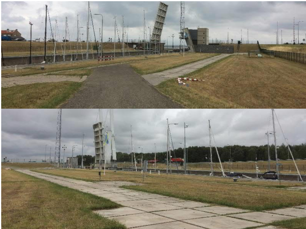
Figuur 3: Terrein van de Zandkreeksluis
