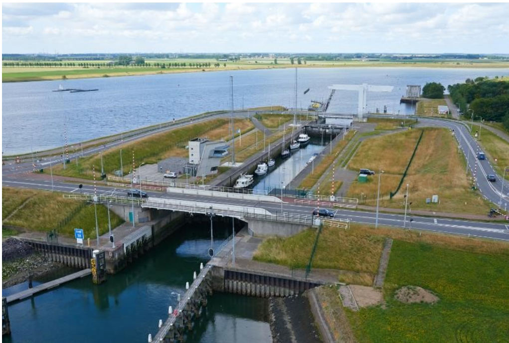
Figuur 1: De Zandkreeksluis in de Zandkreekdam
