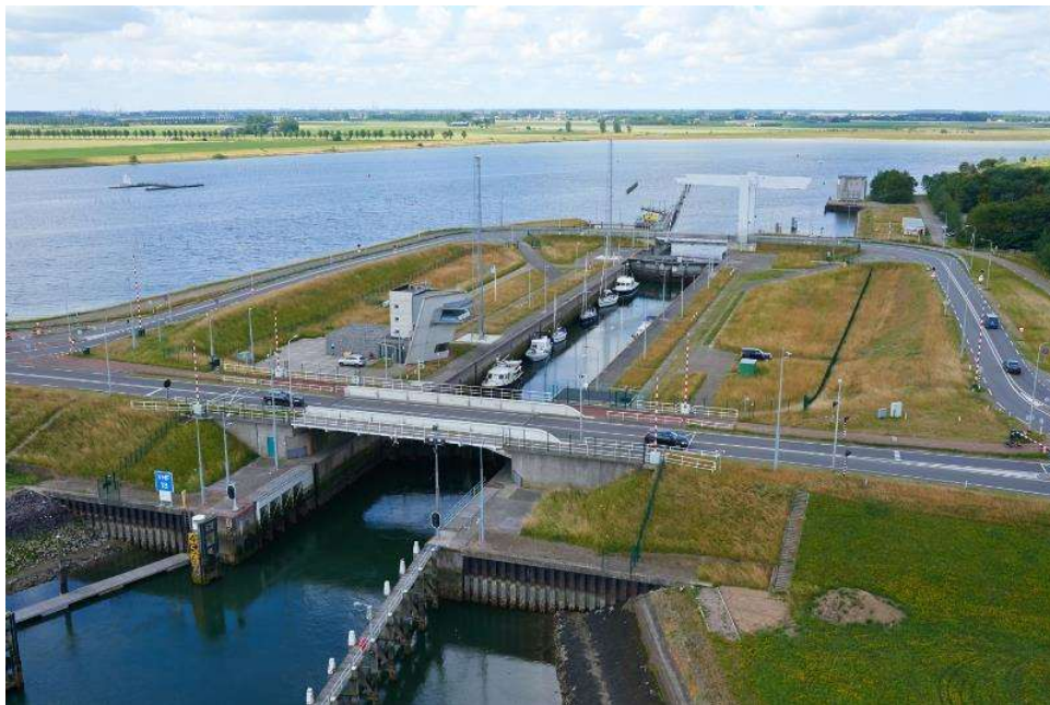
Figuur 1 De Zandkreeksluis in de Zandkreekdam
