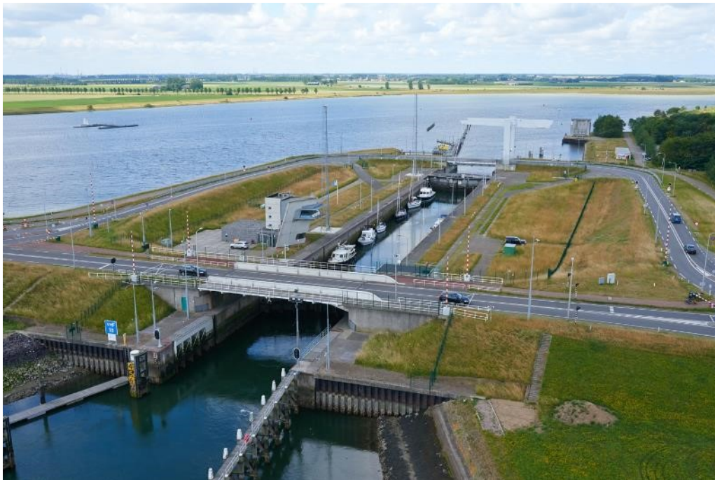
Figuur 1 De Zandkreeksluis in de Zandkreekdam
