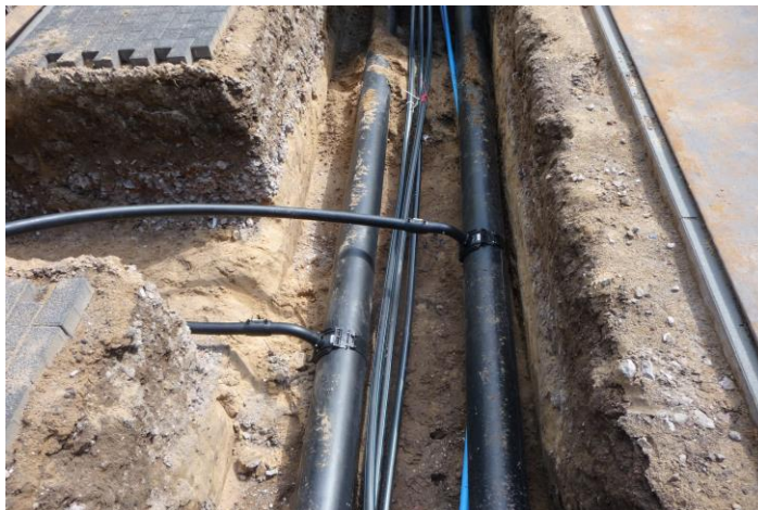
Figuur 7.8 | voorbeeld twee-pijps distributienet met aftakking
