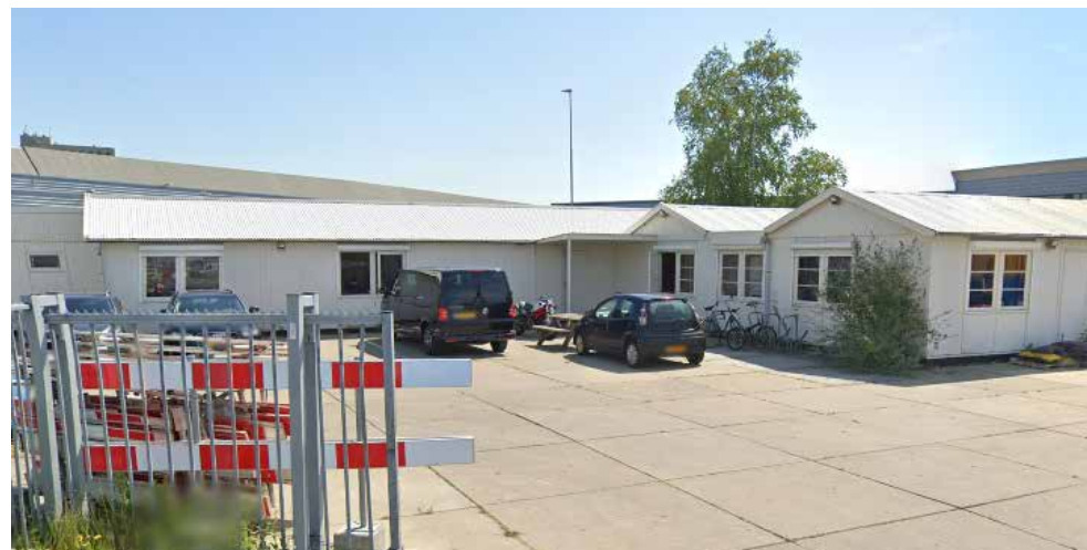
▲ Verharding met betonplaten op het tijdelijke gemeentelijke terrein met keet.
