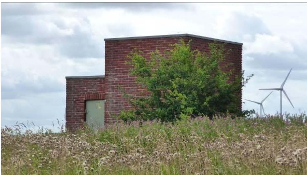
Figuur 1.8 Transformatorhuisje binnen het projectgebied.
