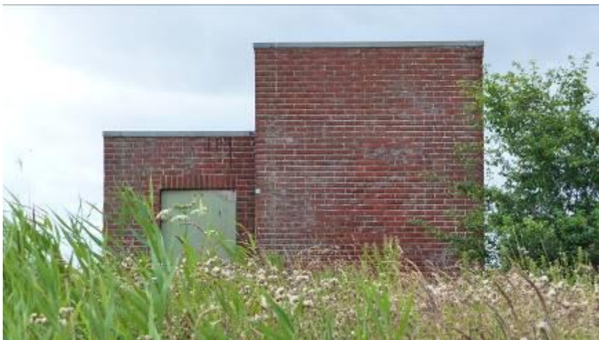
Figuur 4.2 Het transformatorhuisje binnen het projectgebied.
