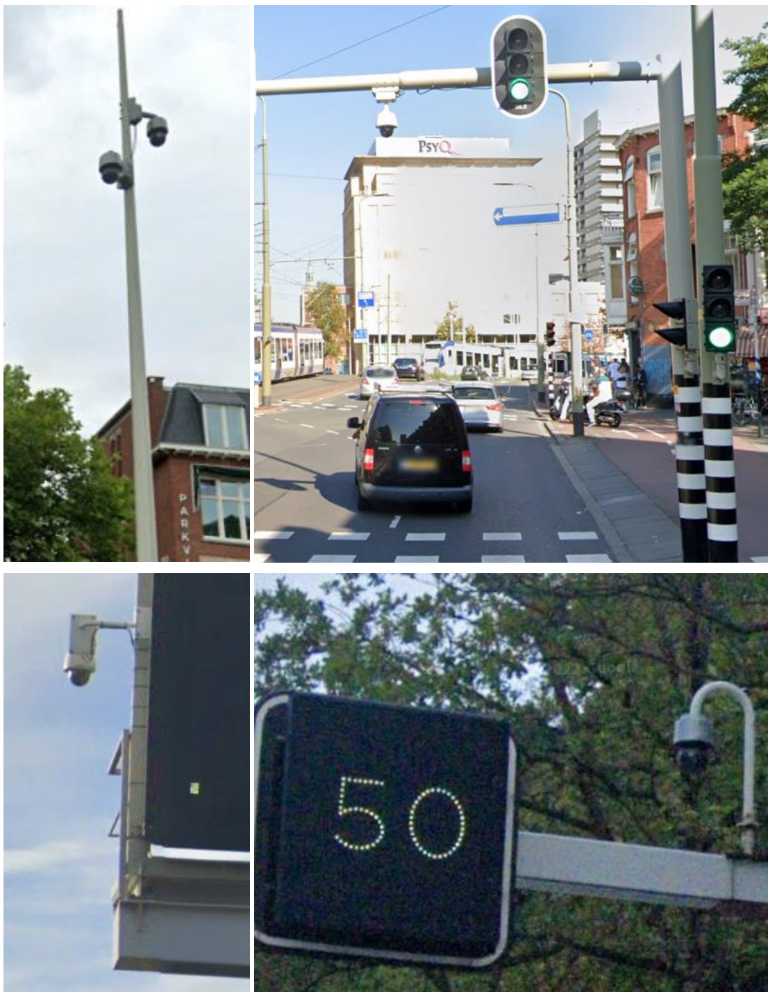
Figuur 8: voorbeeld montage op een mast (linksboven) en een zweepmast (rechtsboven), hoekmontage (linksonder) en opzetmontage (rechtsonder)..
