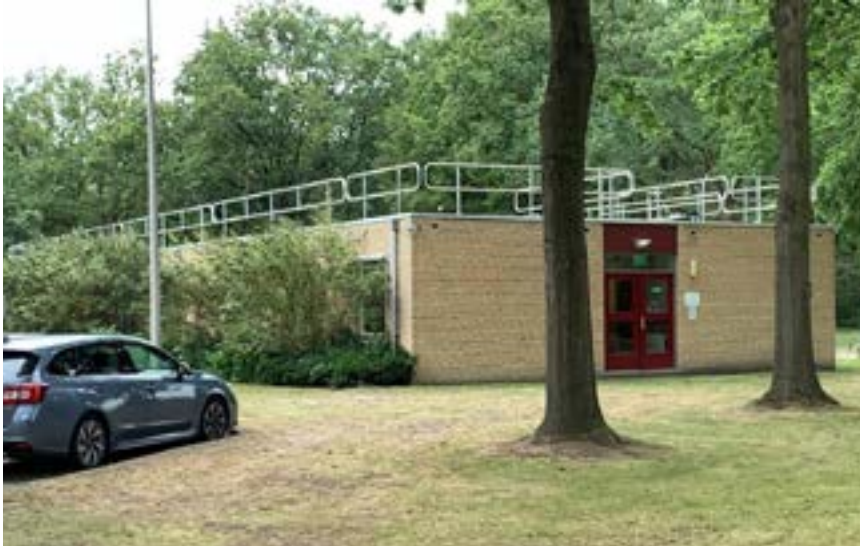
Ongewenste toevoeging van herwerk (o.a. vanuit architectonisch en materiaal oogpunt).
