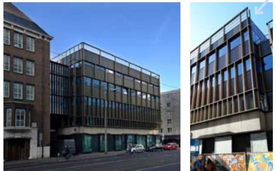
Plein-KalvermarktComplex (PKC), gebouw H, waarbij een nieuwe gevel ontworpen is en waarbij de gevel is opgetrokken zodat er veilig op het dak zonder voorzieningen gewerkt kan worden.
