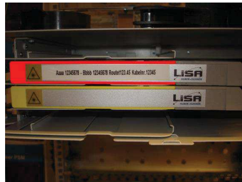
Figuur 6: Labeling glasvezelpanelen NAFIN
