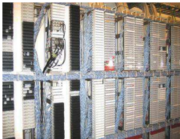
Figuur 4: Voorbeeld van een LSA+ hoofdverdeler
