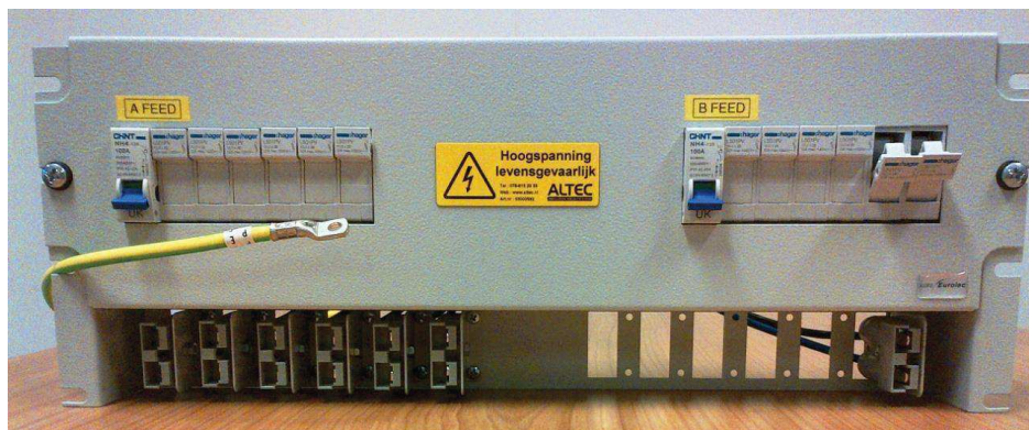
Figuur 13: -48V DC-paneel met glaszekeringen en lastscheider
