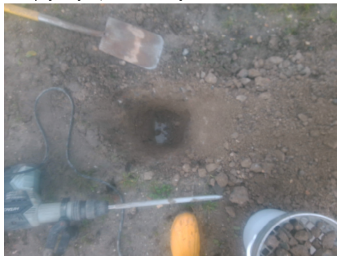
Fotonummer: 22 Omschrijving: Boring 214
