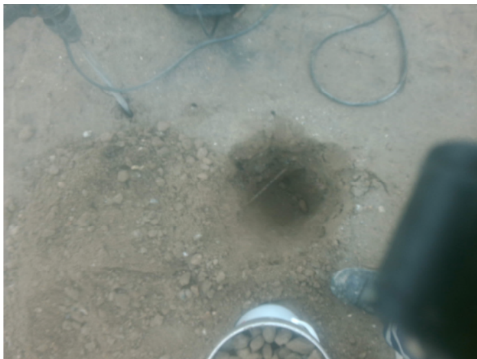
Fotonummer: 7 Omschrijving: Boring 206
