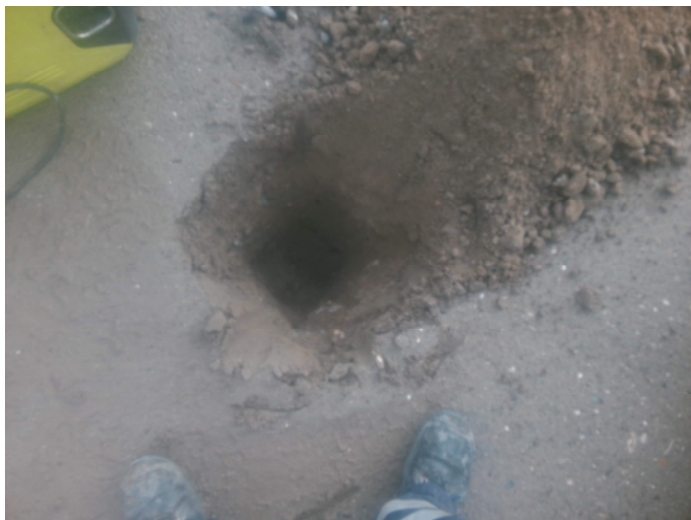
Fotonummer: 19 Omschrijving: Boring 213
