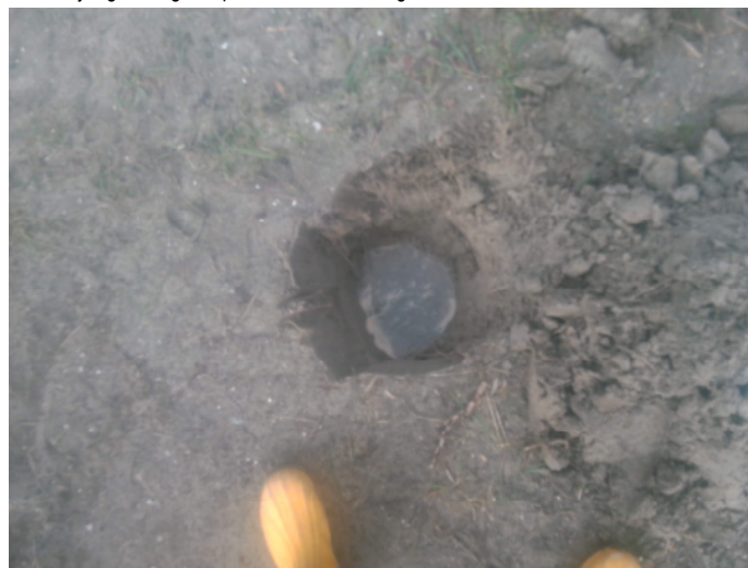
Fotonummer: 26 Omschrijving: Boring 217
