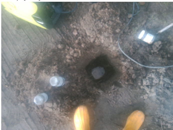
Fotonummer: 29 Omschrijving: Boring 219
