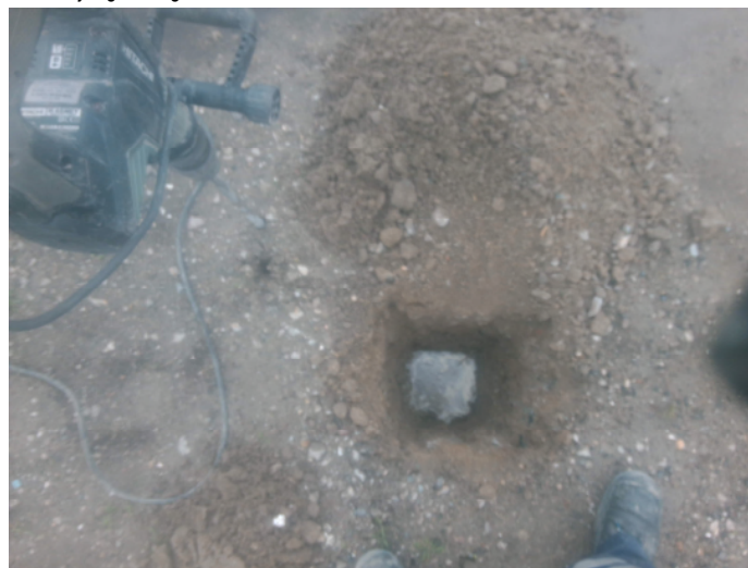
Fotonummer: 6 Omschrijving: Boring 205
