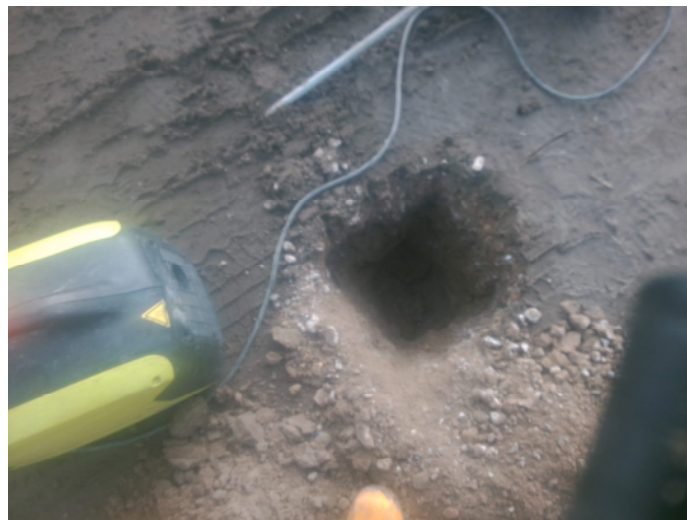
Fotonummer: 32 Omschrijving: Boring 221
