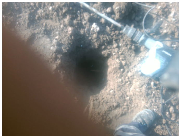
Fotonummer: 2 Omschrijving: Boring 201
