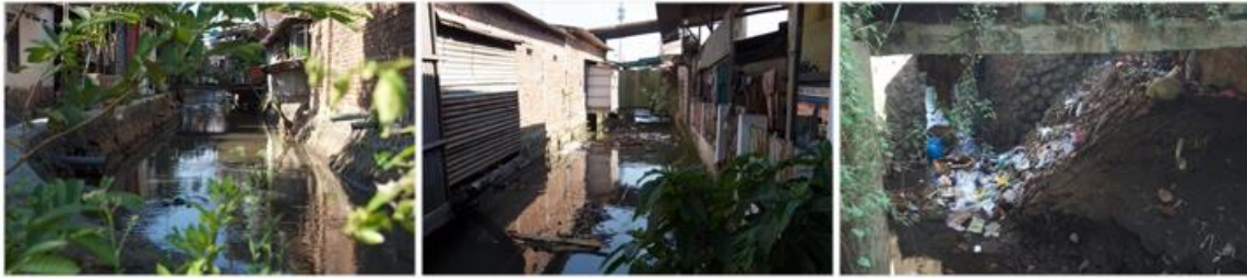
Gambar 5-21 Saluran Irigasi Juga Digunakan Untuk Mengalirkan Air Hujan, Meskipun Kapasitas Debit Berkurang Karena Gabungan Pengurangan Lebar/Kedalaman Saluran dan Akumulasi Limbah Padat yang Terjebak di Dekat Outlet (Pintu Air)
