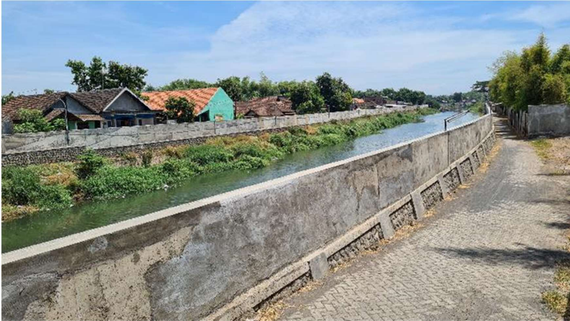
Gambar 6 Tanggul sungai beton yang baru dibangun dan ditinggikan (1,5 m) di dekat Jembatan Kraton.
