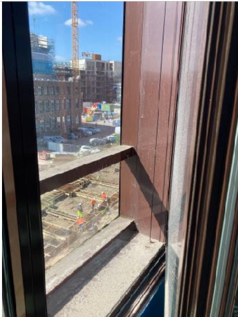
23. Gevelramen dubbele kozijnen met goot
