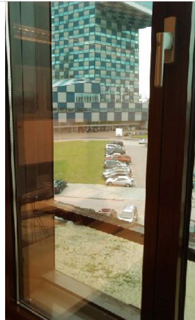
22. Gevelramen dubbele kozijnen met goot
