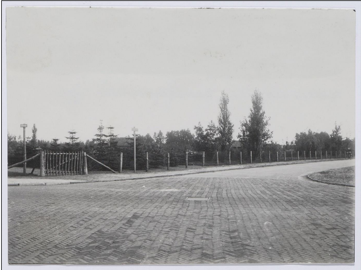
Figuur 25. De kruising van de Noordewierweg met het Isseltseveld, kijkende in de richting van deze laatste. De weg bestaat uit klinkers, de bermen lijken onverhard. Foto uit circa 1935.
