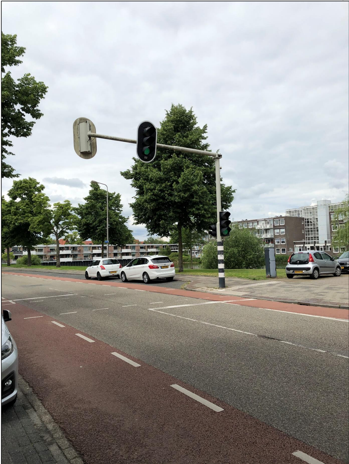
Figuur 40. Een stoplicht nabij de Matthias Withoosstraat, waaronder de nodige kabels voor de stroomvoorziening zullen liggen. Ook valt te denken aan de aanwezigheid van sensoren onder het wegdek die het stoplicht aansturen.
