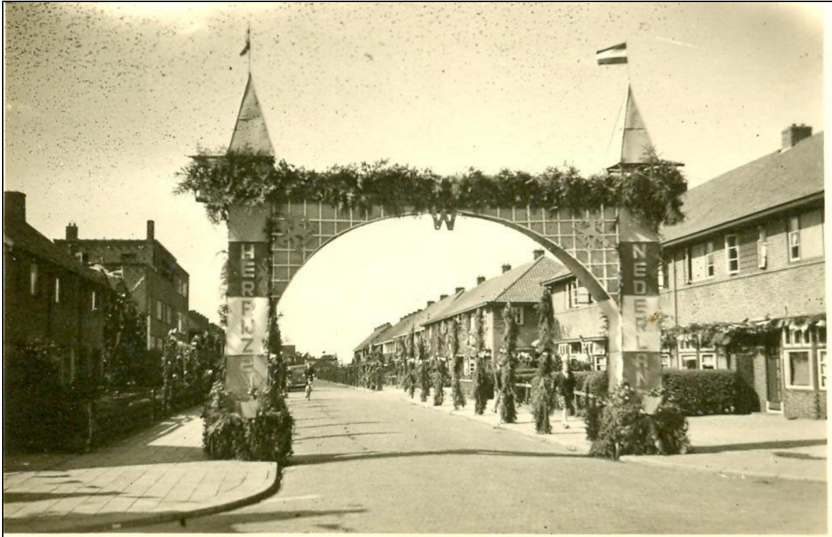
Figuur 26. De Noordewierweg, kijkende in westelijke richting vanaf de kruising met de Anemoonstraat, anno 5 mei 1946. De klinkerbestrating en de betegeling van de stoep zijn duidelijk te zien. Rechts valt te zien dat sommige, doch niet alle huizen een tuin hadden.
