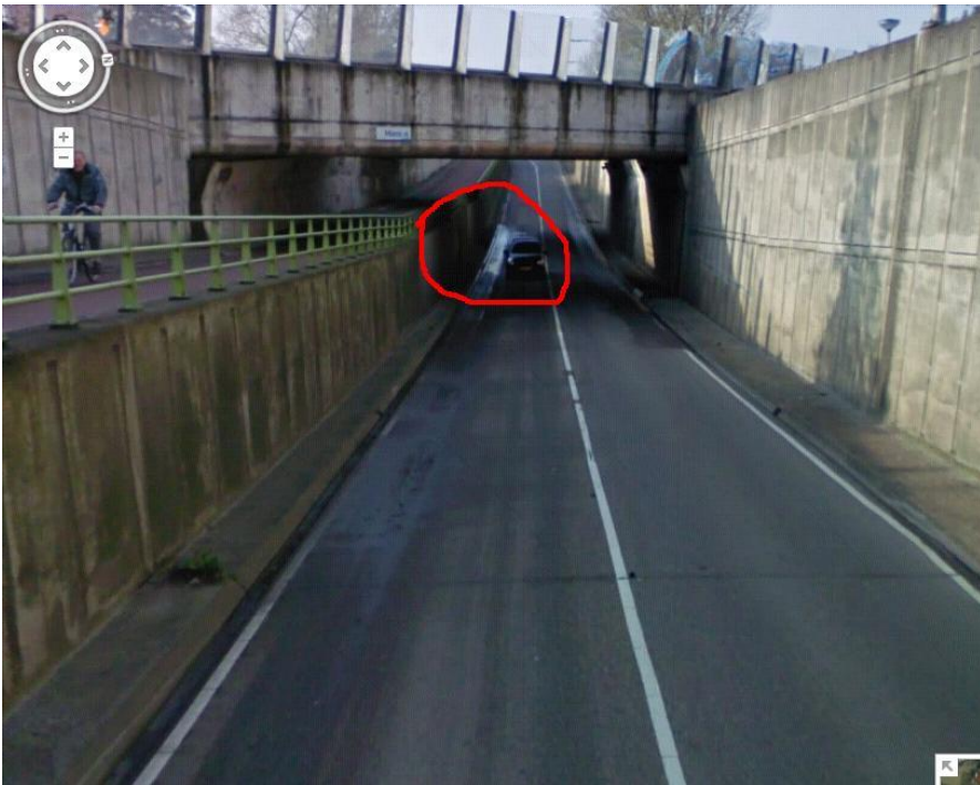
Rioolgemaal 409 – Poeldijkseweg tunnel
