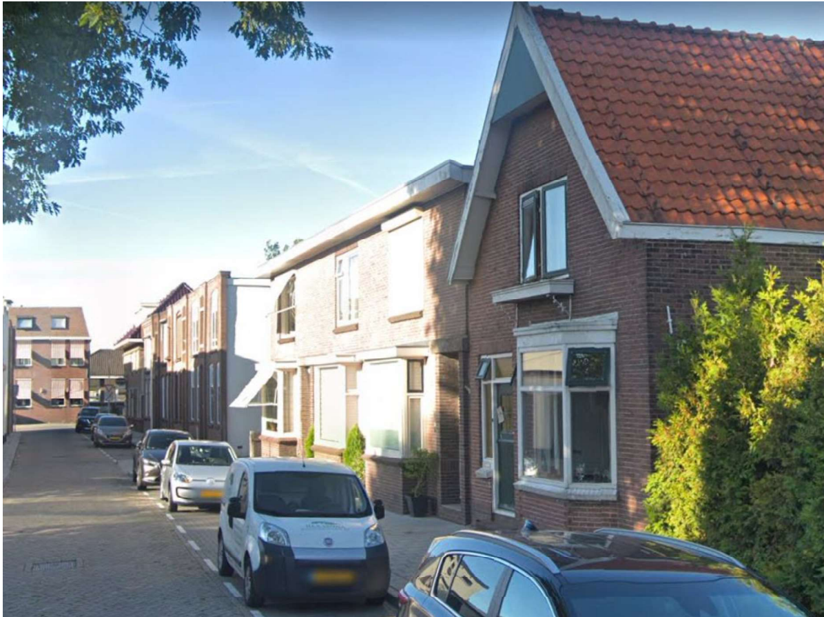
Vleermuisgeschikte bebouwing met gaten onder de daklijst aan de Julianastraat ten oosten van plangebied. Figuur 2-5. Foto's tonen geschiktheid voor vleermuizen in de omgeving van het plangebied (bron: google.nl/streetview ).
