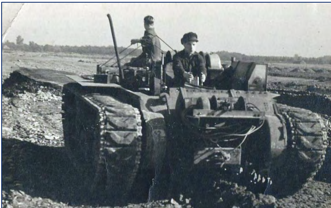
Afbeelding 3: Aanleg vliegveld Y-44.
