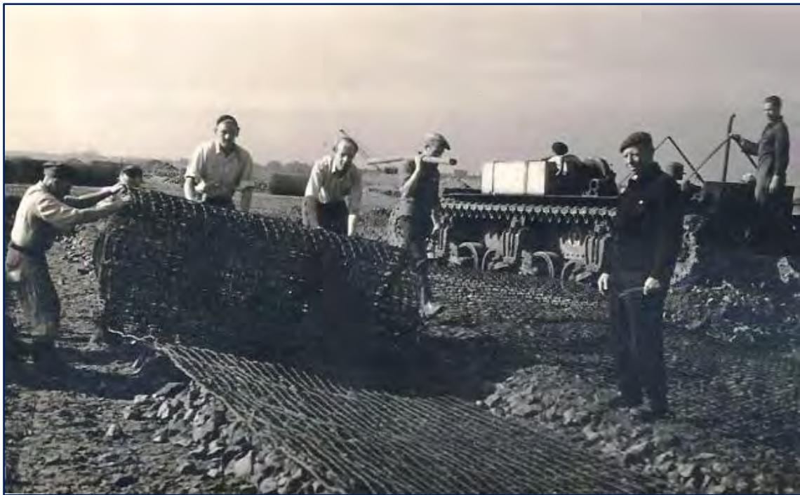
Afbeelding 5: Aanleg vliegveld Y-44.
