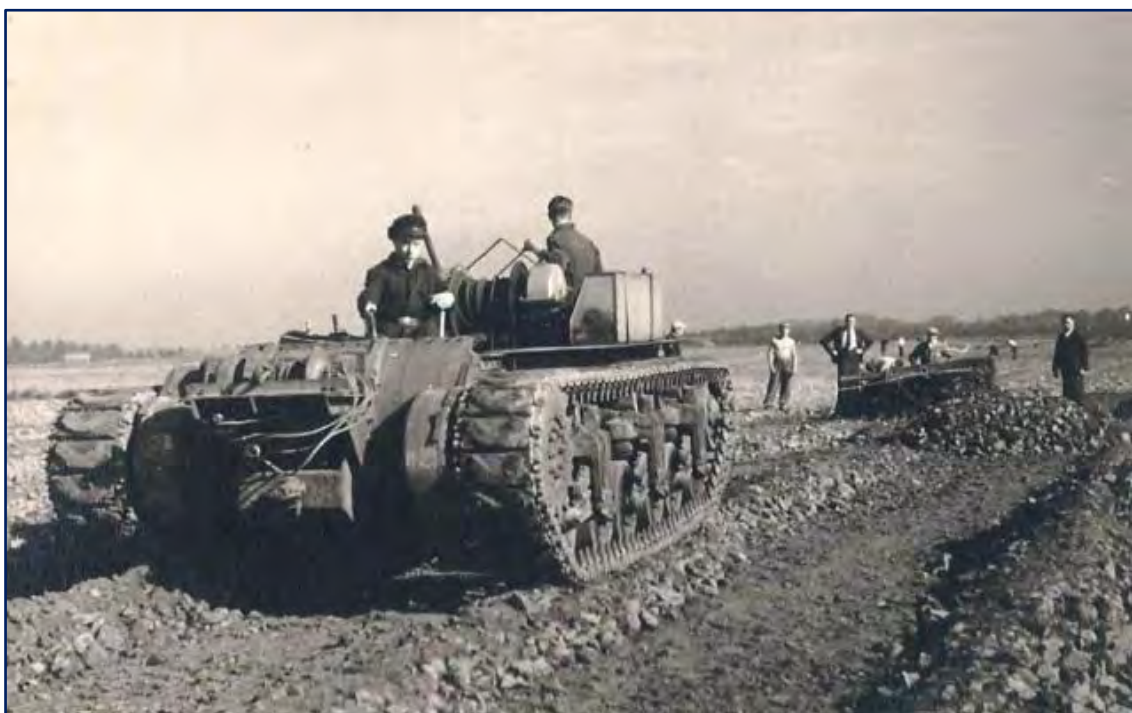
Afbeelding 4: Aanleg vliegveld Y-44.
