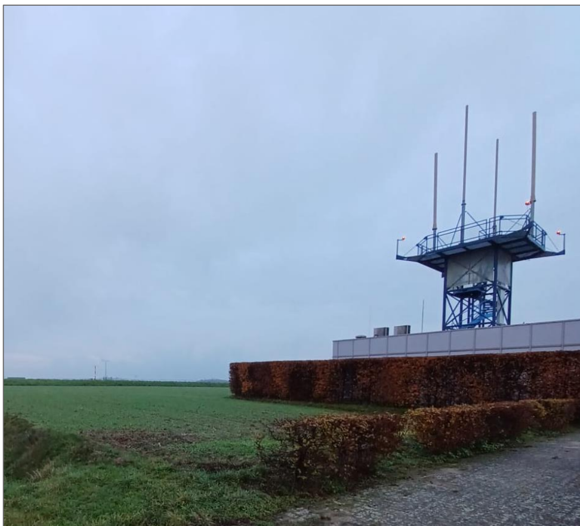
Figuur 1.3: Radar toren in het plangebied.
