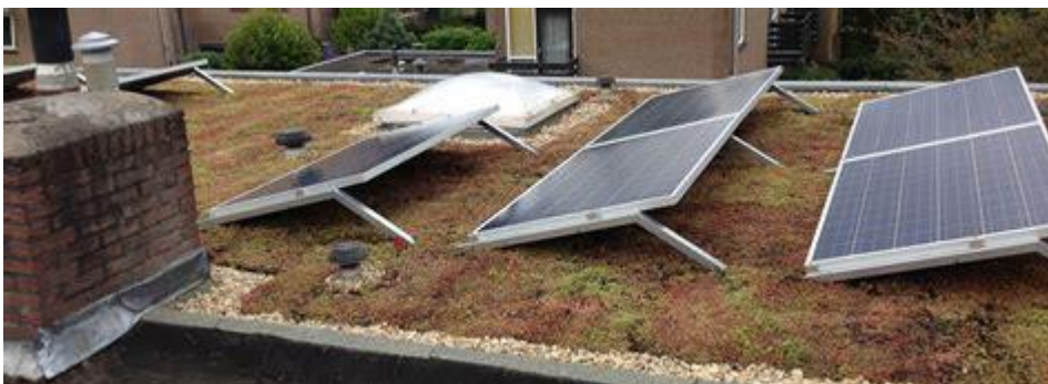
Op bepaalde plaatsen kunnen sedumbegroeiing en zonnepanelen gecombineerd worden
