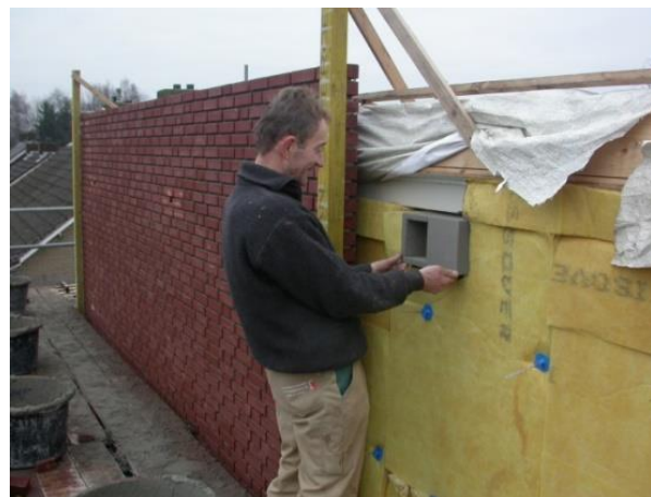
De nestkasten werden toen bij een aantal nieuw te bouwen huizen in de muurisolatie van de spouwmuur ingemetseld
