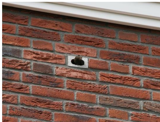
Cementbetonnen nestkast geheel in de spouwmuur ingemetseld. Een voorzetsteen met invliegopening geeft toegang tot het nestgedeelte
