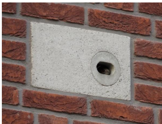
Cementbetonnen nestkast frontaal ingemetseld met uitneembare opening
