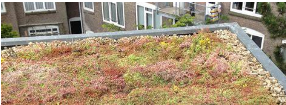
Sedumbegroeiing op een plat dak isoleert warmte en helpt bij CO 2 reductie
