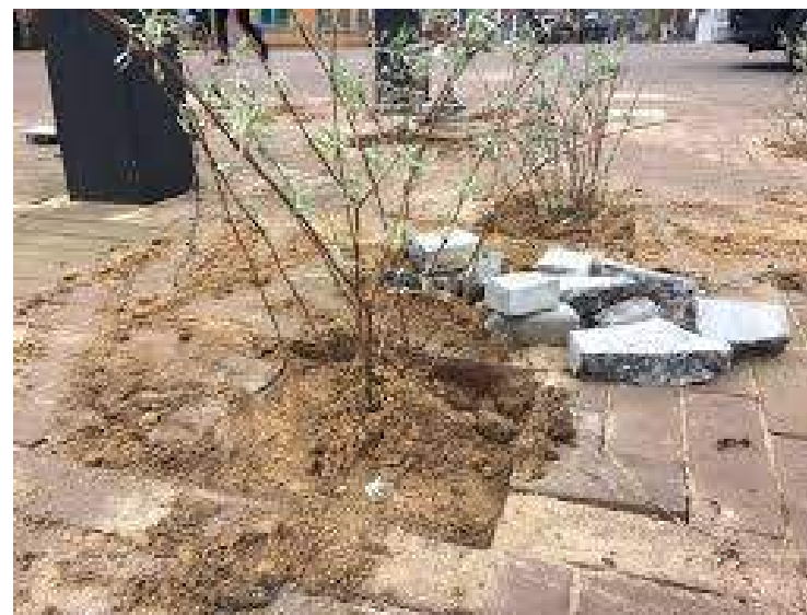
Foto; Voorbeeld Operatie Steenbreek groen voor steen in uitvoering.
