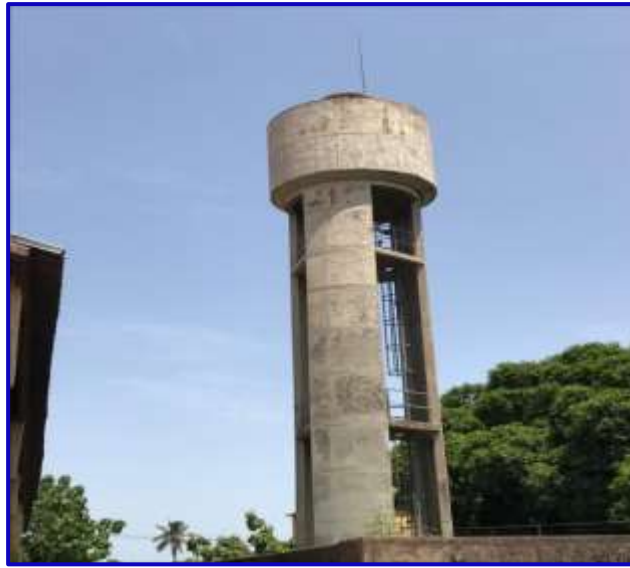
Photo 4 : Vue du château d'eau
