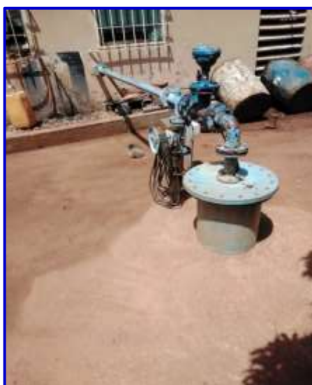
Photo 1 : Vue du forage
