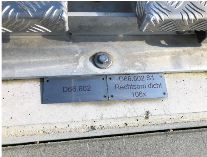
Foto: Aanduiding unieke code van object en bedieninstructie afsluiter
