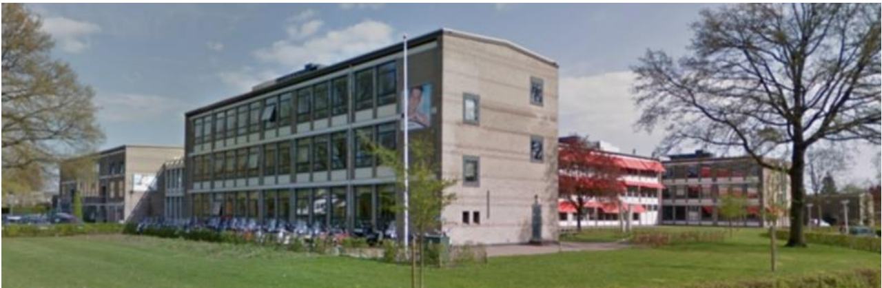
Figuur 1 – Het huidige Bonhoeffer College te Enschede (Aan bovenstaande afbeelding kunnen geen rechten worden ontleend).
