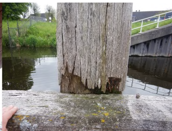
Figuur 13: Materiaalafname contactvlak wrijfgording op paal
