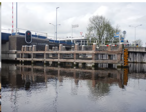
Figuur 29: Remmingswerk Noord-West
