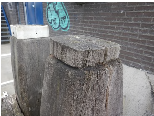
Figuur 10: Ontbrekende paalmuts
