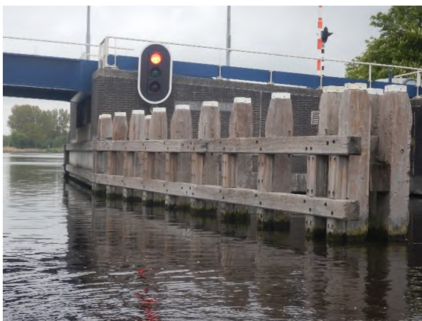
Figuur 25: Remmingswerk Zuid-Oost
