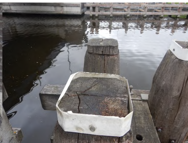
Figuur 11: Beschadigde/ kapotte paalmuts
