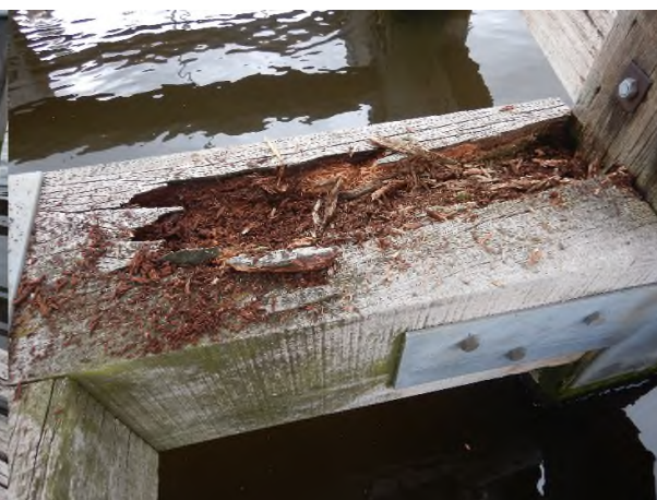
Figuur 21: Groeven en wegotting horizontale delen
