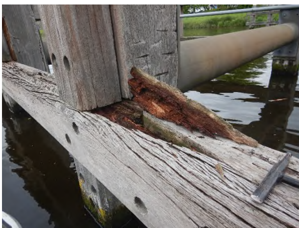
Figuur 20: Groeven en wegotting horizontale delen
