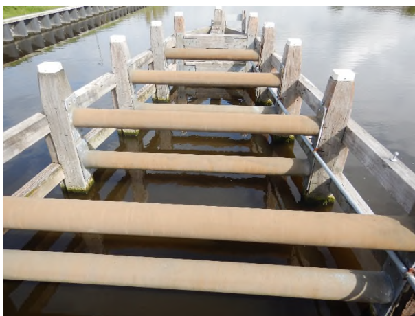
Figuur 28: Bovenaanzicht Remmingswerk Noord-West
