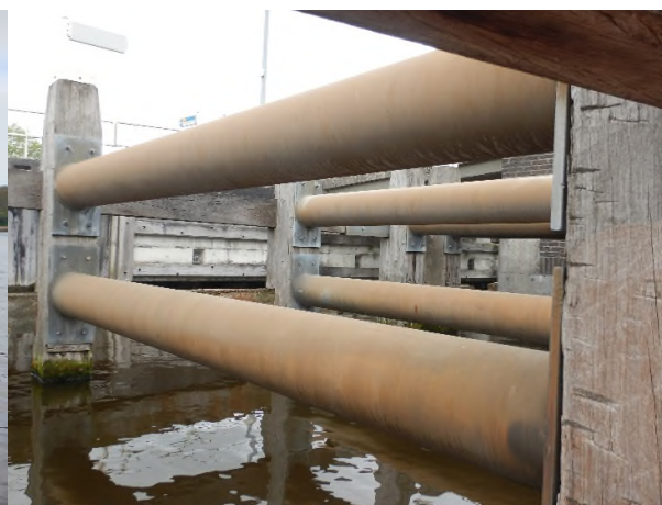
Figuur 32: Stalen buizen Zuid-West
