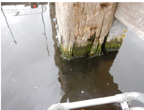
Figuur 16: Materiaalafname paal
