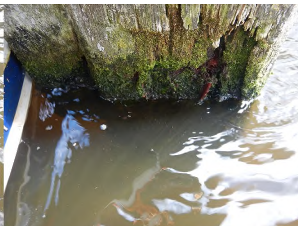
Figuur 15: Materiaalafname paal
