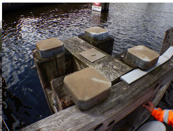
Figuur 19: Dukdalf Remmingswerk Deel 1
