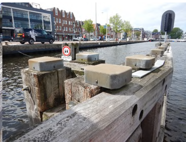
Figuur 11: Te kleine paalmuts
