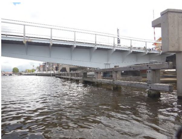
Figuur 21: Remmingswerk Deel 1
