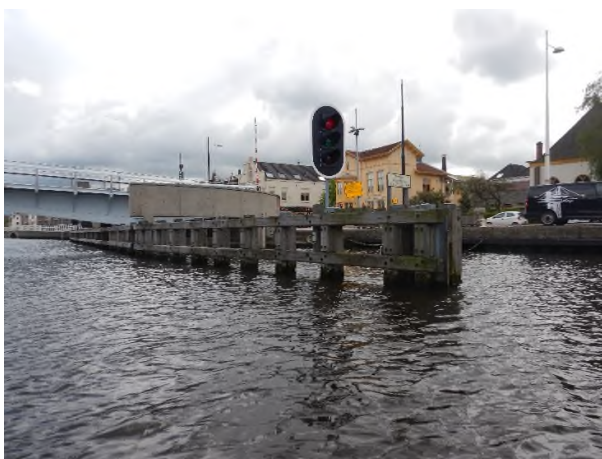
Figuur 18: Remmingswerk Deel 1
