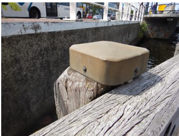
Figuur 10: Te kleine paalmuts
