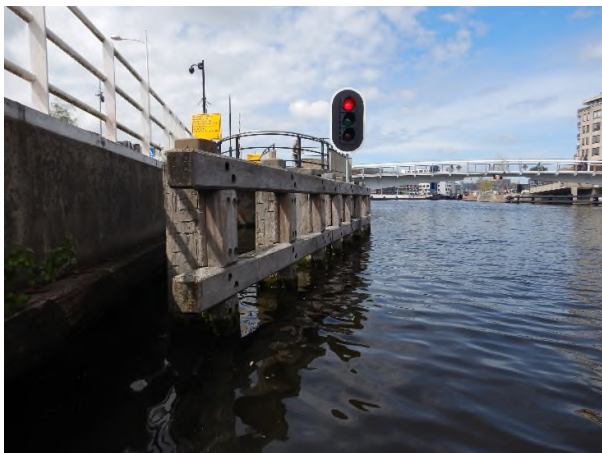
Figuur 24: Remmingswerk Deel 1
