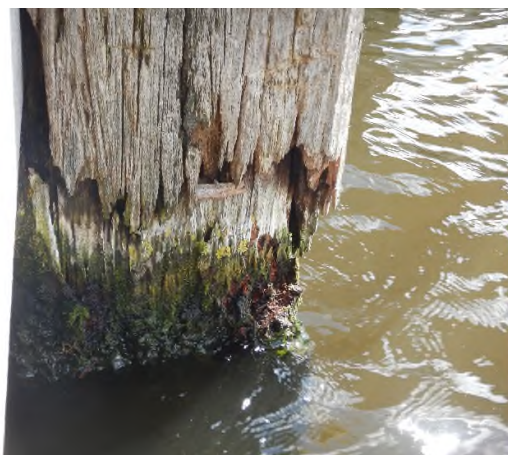
Figuur 14: Materiaalafname paal
