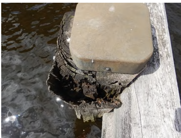
Figuur 12: Houtrot t.g.v. te kleine paalmuts
