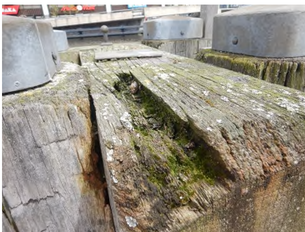
Figuur 16: Materiaalafname bovenkant kruis dukdalf
