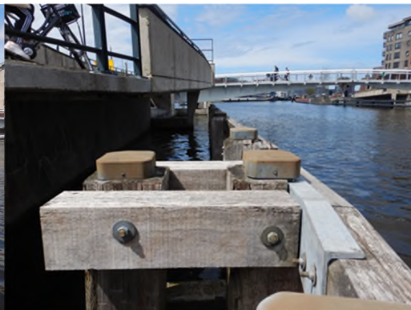
Figuur 25: Dukdalf Remmingswerk Deel 1
