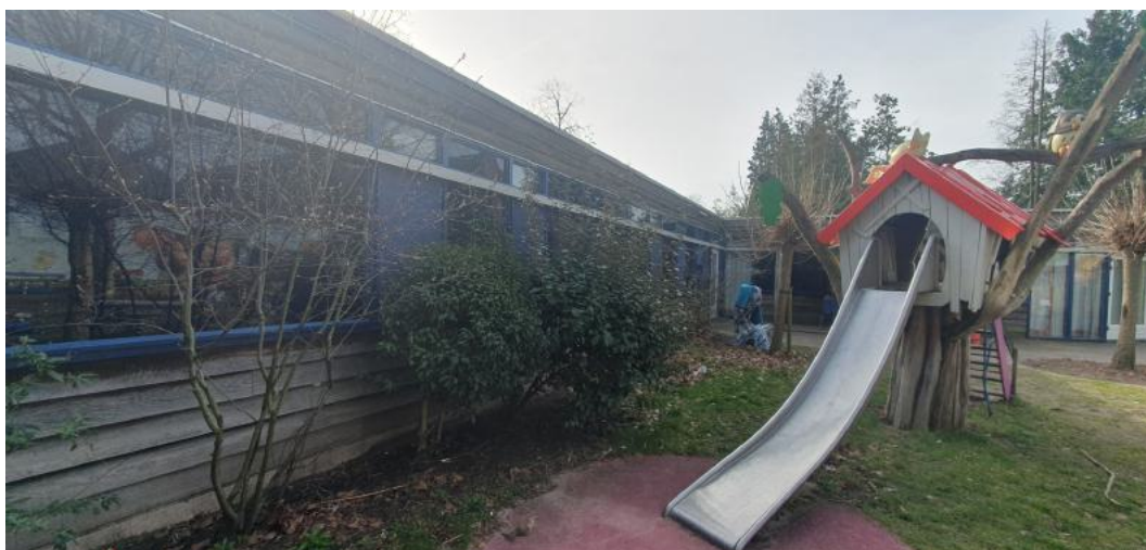
Foto 2.1 Te slopen laagbouw Aartshertogenlaan 23, Den Bosch..
