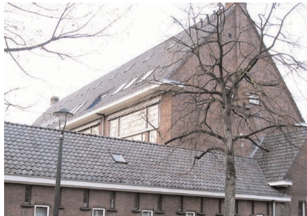
Deel achtergevel met deel linkerzijgevel (Mgr. Zwijsenstraat)
