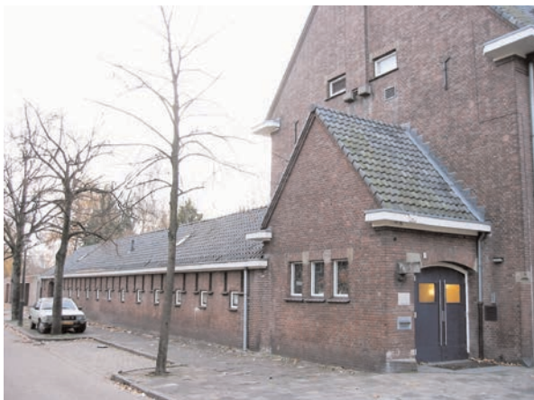
Linkerzijgevel (Mgr. Zwijsenstraat)
