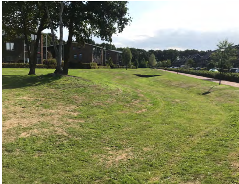
Een laaggelegen gebied doet bij hevige regenval dienst als opvangbassin om water te bufferen en deels te infiltreren
