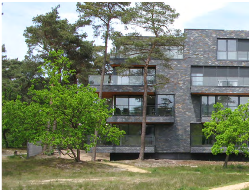
Maaiveld loopt door tot de gevel; balkons zweven boven het maaiveld.
