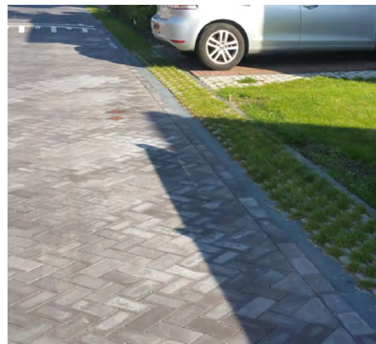
Randen van grasbeton beperken de hoeveelheid verharding
