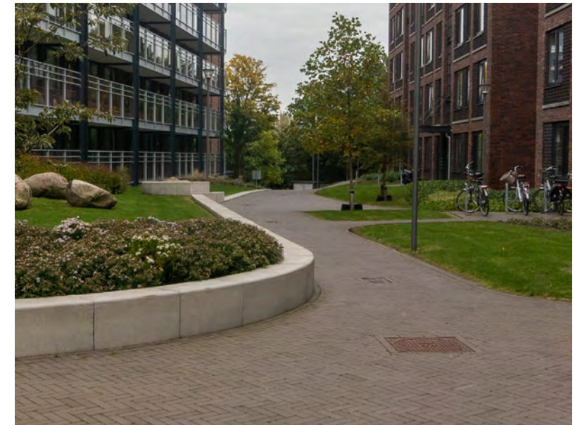
Betonranden ter accentuering van hoogteverschillen en ter gebruik als zitrand
