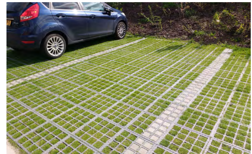
Parkeerplaatsen worden uitgevoerd in halfverharding / grasbetontegels voor de waterdoorlatendheid
