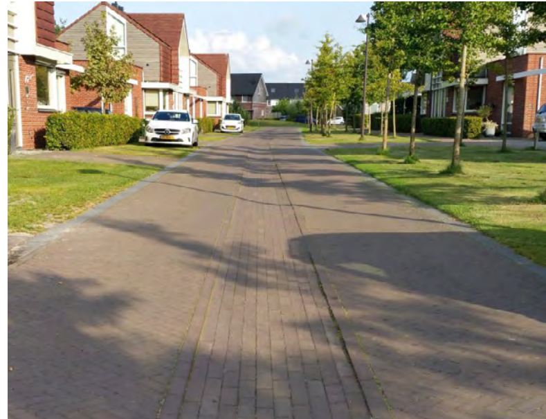
Bestratingsmateriaal heeft een duurzaam karakter: (elementen) verharding met afstroomvoorziening voor hemelwater.
