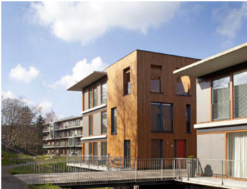
Openingen en toegang tot de blokken
