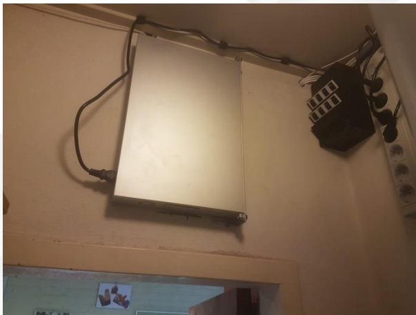
Montage boven het kozijn vanwege ruimtegebrek.
