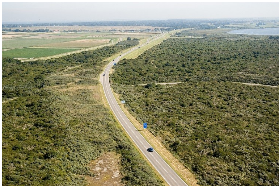
Op een 80-km/uur weg is de breedte van de obstakelvrije ruimte 10 m vanaf de kantstreep. Foto archief Rijkswaterstaat.
