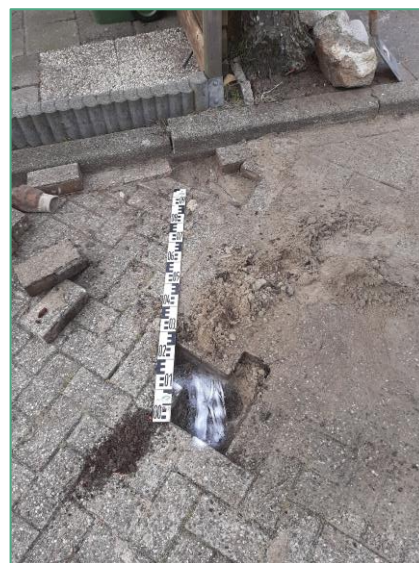
Afbeelding 3.15 Beworteling onder de straat
