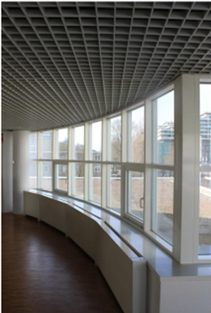
Figuur 10 Gevel 19 (deel)
