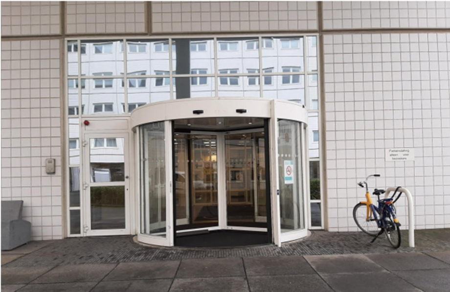
Figuur 13 Gevel hoofdentree
