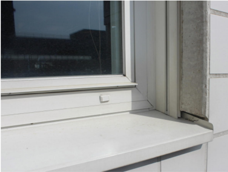
Foto van zetwerk en zijgeleiding zonwering aan de buitenzijde.
