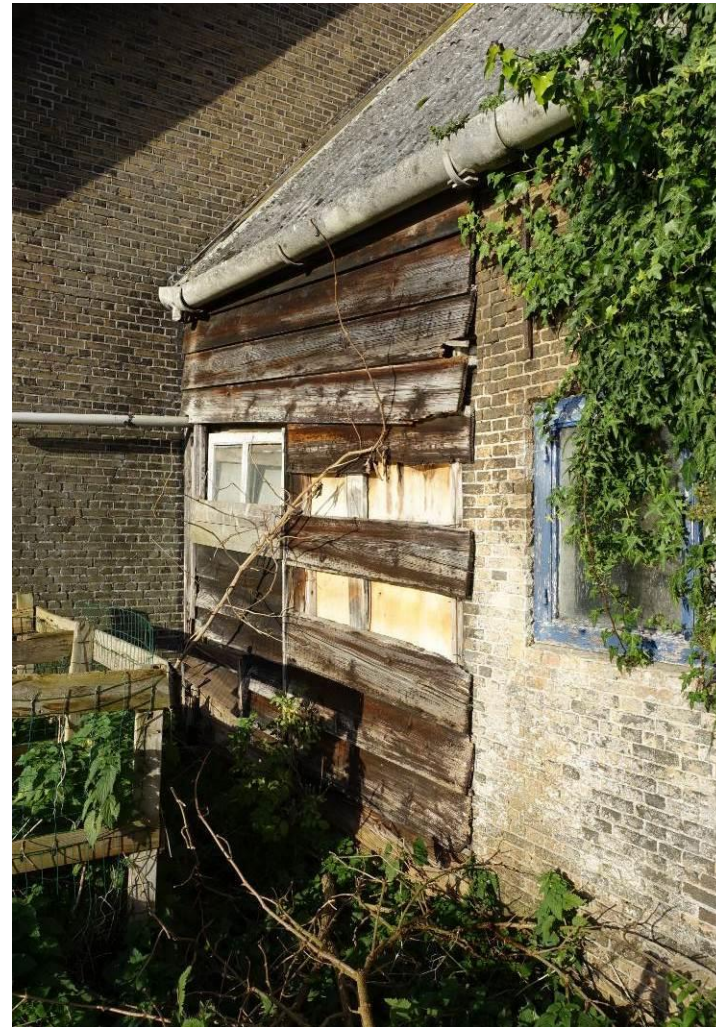
Het tussenlid is vooral door zettingen van aangrenzende schuren vervormd.
