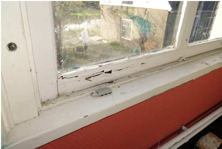
Aangetaste onderdorpel van raam.
