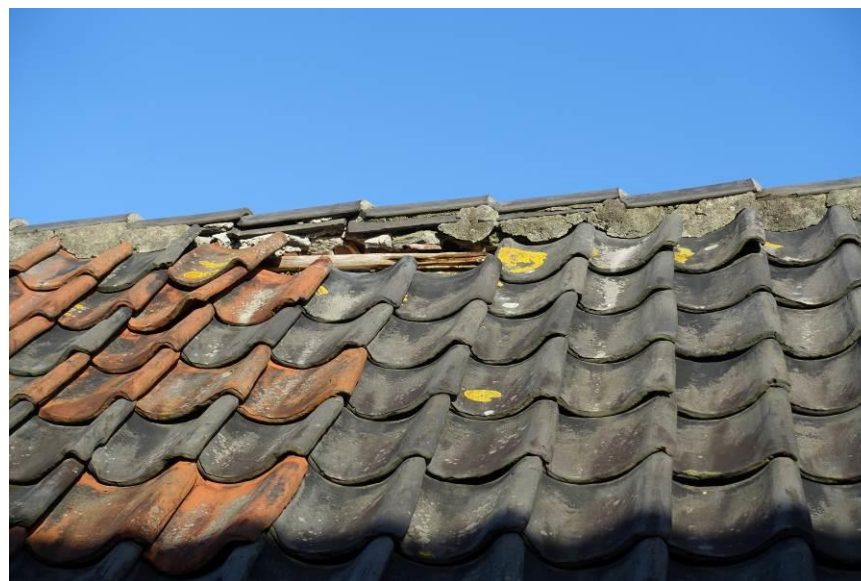
Door weggevalen pannen zijn lekkages ontstaan.
