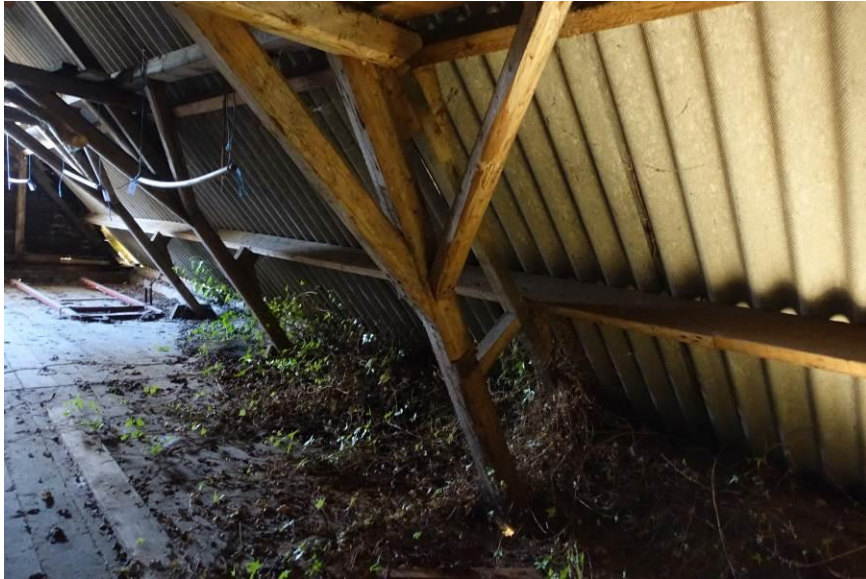
Met het aanbrengen van asbest golfplaten werd ook de constructie gewijzigd.
