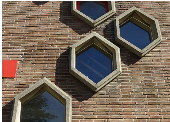
Gevel t.p.v. de zeshoekige ramen
