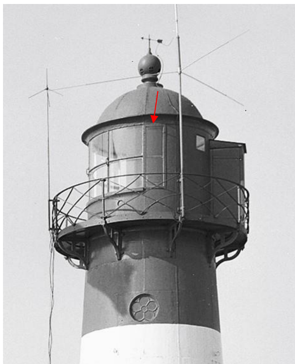
Links: zijaanzicht van het lichthuis met het ontworpen extra raam uit 1968. (collectie Rijkswaterstaat) Rechts: het nieuwe raam op een foto uit 1976. (collectie RCE)
