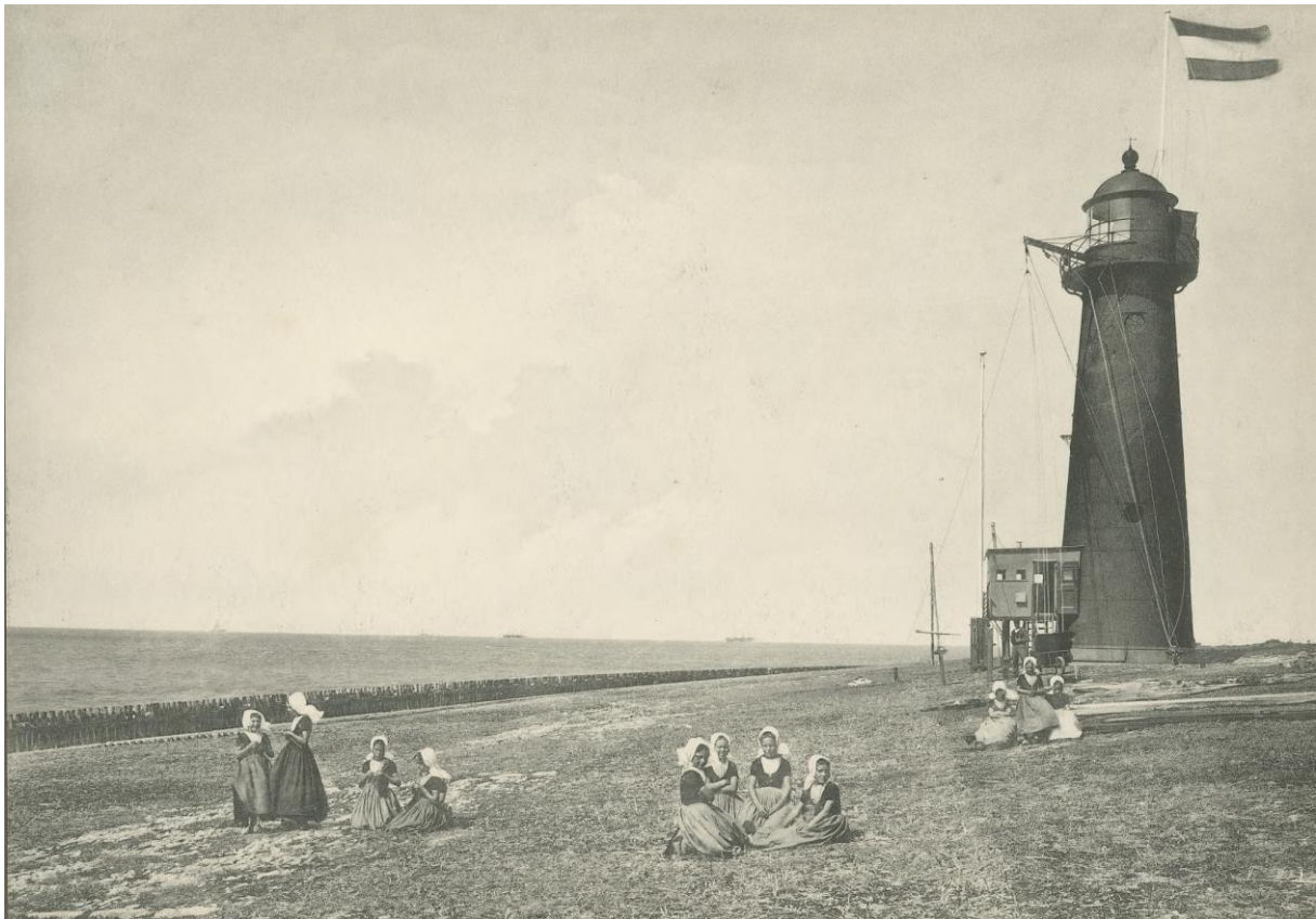
De vuurtoren en het buitenloopse deel van de Zeedijk in 1911; op deze foto is de nieuwe seinmast bovenop de gaanderijvloer zichtbaar. (collectie Zeeuws Archief)
