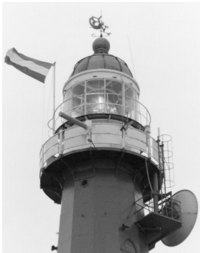
Links: de vuurtoren bij aanvang van de verbouwing van 1960. Op de onderste gaanderij staat een hulplicht als tijdelijke vervanging van de lichtinstallatie. (collectie René Vas, via de Nederlandse Vuurtoren Vereniging)
