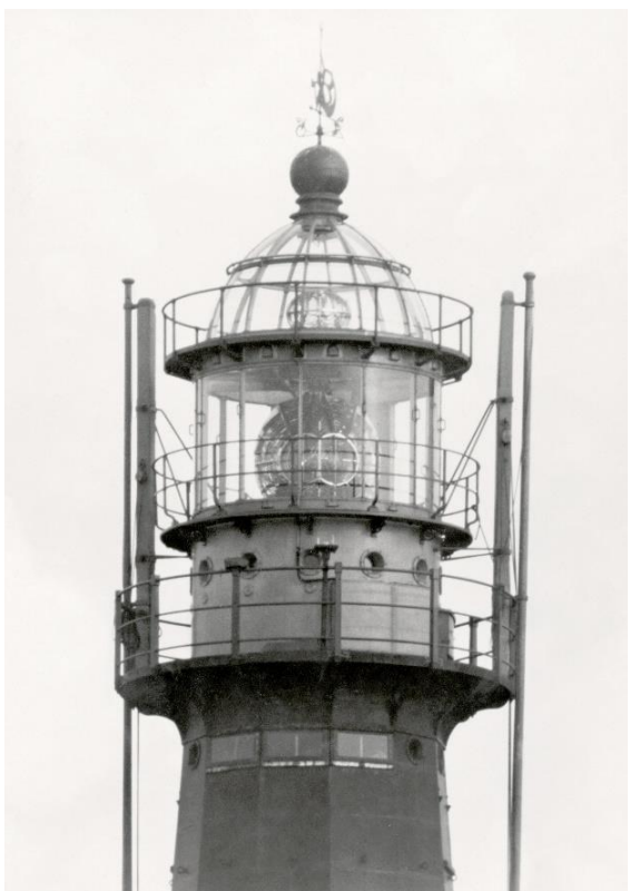
Links: de verbouwde vuurtoren, gezien vanuit het noordwesten in 1925. Het grote maritieme navigatielicht in het lichthuis en het kleinere aviatieklucht in de glazen koepel zijn op de foto goed zichtbaar. De foto toont ook de nieuwe ramen van de wachtkamer op de bovenste bouwlaag van de schacht. (collectie Henk Huis, via de Nederlandse Vuurtoren Vereniging) Rechts: de vuurtoren gezien vanuit het zuiden omstreeks 1930. (collectie Haags Gemeentearchief)
