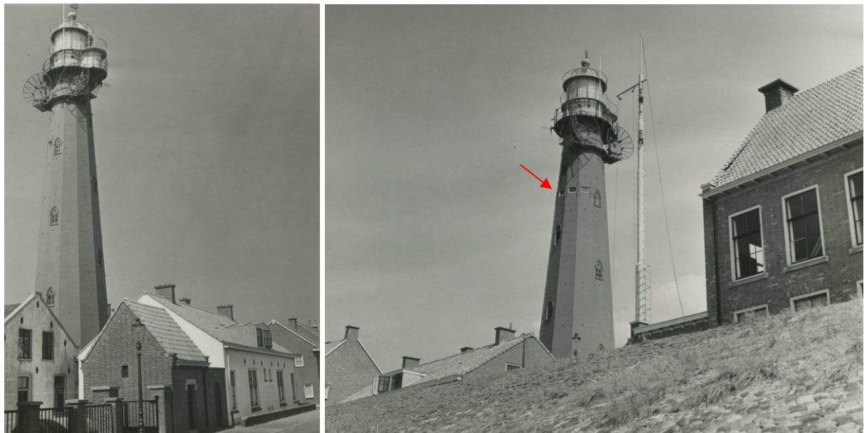
De vuurtoren gezien vanuit het zuiden en het westen in 1955. Op de rechter foto zijn de in 1952 geplaatste ramen van het nieuwe wachtlokaal te zien. (collectie Haags Gemeentearchief)
