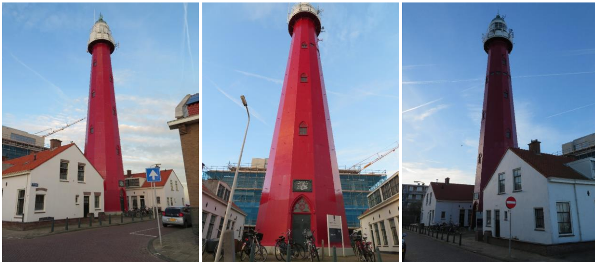
De vuurtoren gezien van het oosten, noordoosten en noorden.
