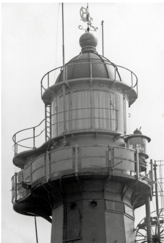
Links: de vuurtoren bij aanvang van de verbouwing van 1960. Op de onderste gaanderij staat een hulplicht als tijdelijke vervanging van de lichtinstallatie. (collectie René Vas, via de Nederlandse Vuurtoren Vereniging)
