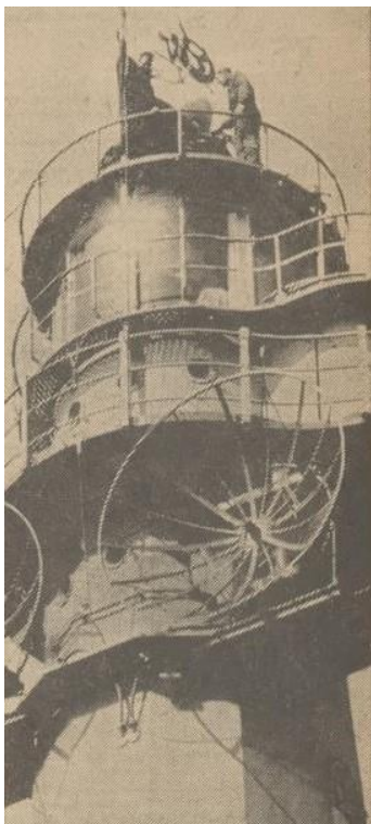
Foto van de vervanging van de glazen koepelruiten door een koperen beplating. (Het Binnenhof d.d. 30 juli 1958)
