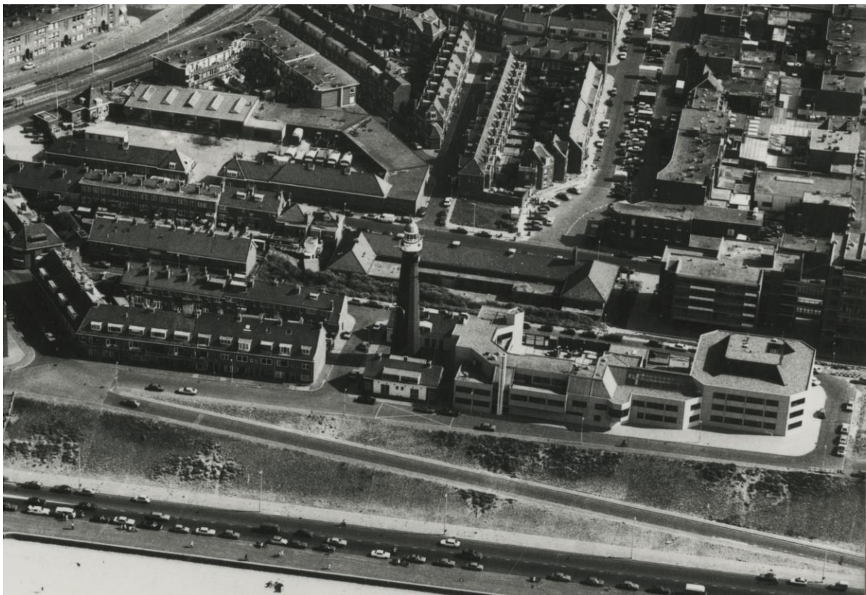
De vuurtoren en de twee resterende dienstgebouwen naast de nieuwbouw van de TDK in 1980. De foto laat goed zien hoe de directe omgeving van de vuurtoren in de loop van de 20 e eeuw is verstedelijkt. (collectie Haags Gemeentearchief)
