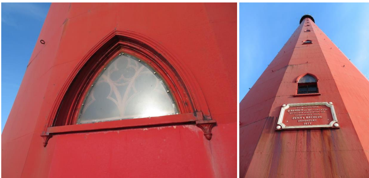
Links: raam op niveau van de begane grond. Rechts: opgaand werk aan de zuidwestzijde van de toren.
