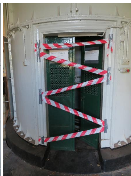
Kuip op niveau van de begane grond.
