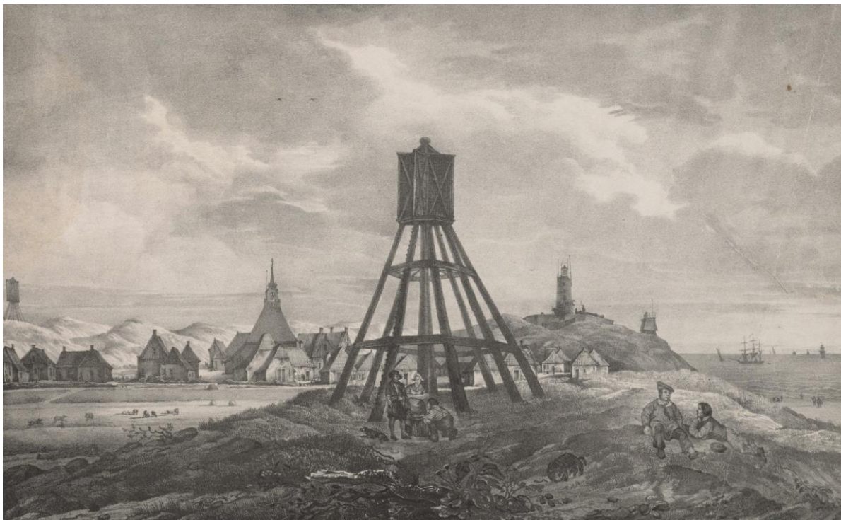
Huisduinen gezien vanuit het noorden in circa 1830. Op de voorgrond en geheel links staan houten kapen. Op de duin "Kijkduin" ligt het Fort Kijkduin en de daarop gesitueerde stenen vuurtoren uit 1822. (collectie Noord-Hollands Archief)
