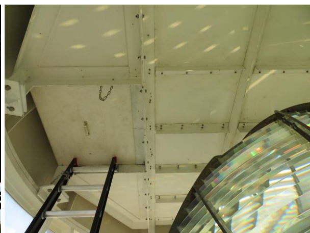
Tussenvloer in de koepel.
