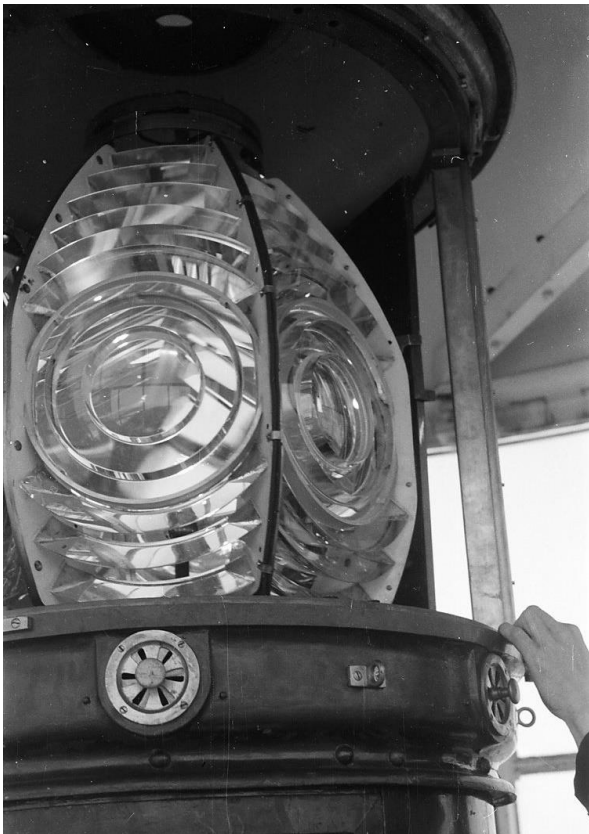
Links: het in 1945 geplaatste noodlicht. (collectie Nederlands Fotomuseum) Rechts: de optiek van het definitieve licht in een testopstelling in het Proefstation van 's-Rijks Kustverlichting te Scheveningen in 1949. (Henk Huis, via de Nederlandse Vuurtoren Vereniging)
