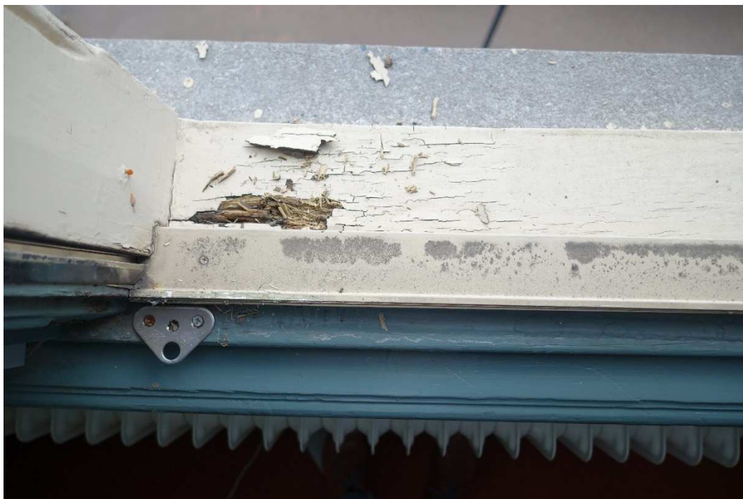
14. 15. De onderdorpels zijn in verschillende staten van ontbinding. Het schilderwerk is altijd zeer slecht.
