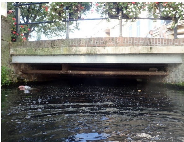
Foto 03: Zijkant brug zijde Kleiweg
