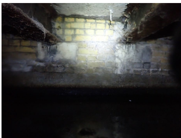
Foto 11: Liggers in metselwerk landhoofd
