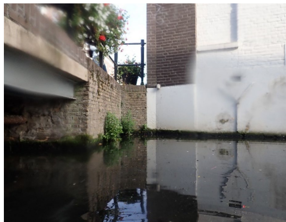
Foto 04: Deel landhoofd oorspronkelijk dek
