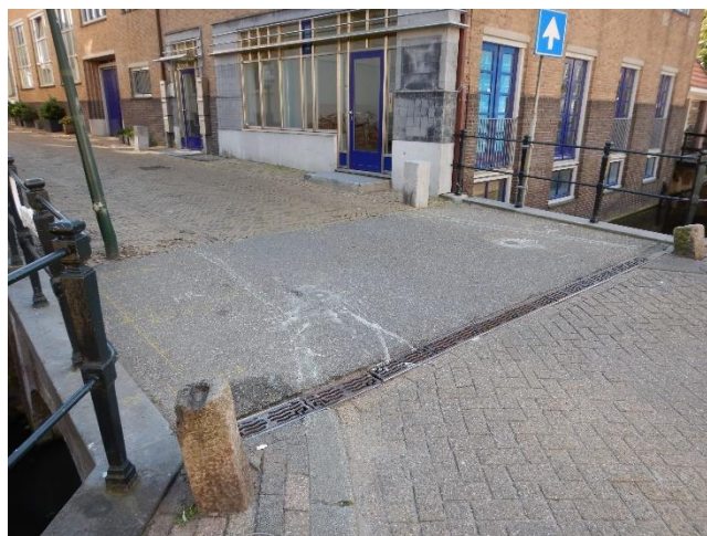
Afbeelding 3: Rijvloer en draingoot gezien vanuit het westen
