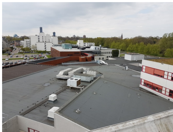
Overzicht daken gezien v.a. gebouw J (zuid)
