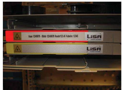
Figuur 6: Labeling glasvezelpanelen NAFIN
