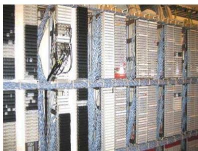
Figuur 4: Voorbeeld van een LSA+ hoofdverdeler
