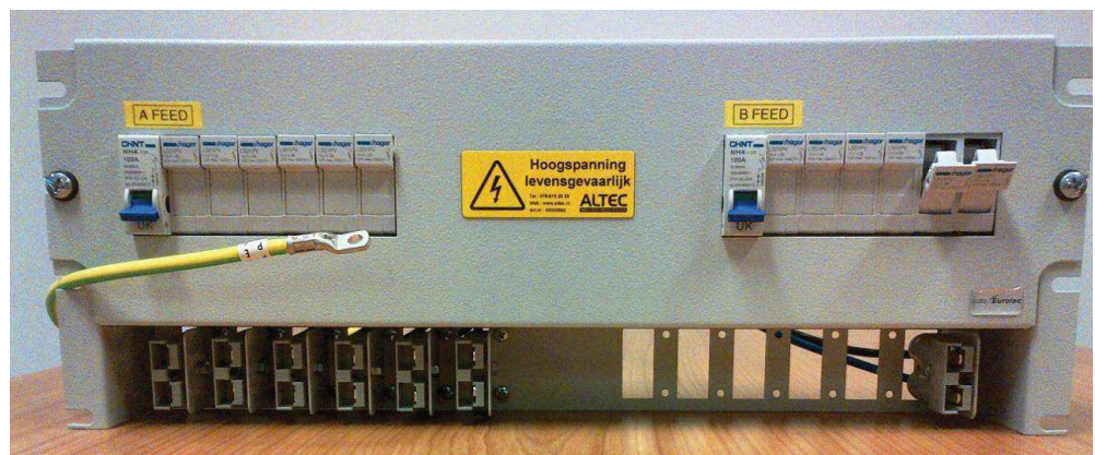
Figuur 13: -48V DC-paneel met glaszekeringen en lastscheider
