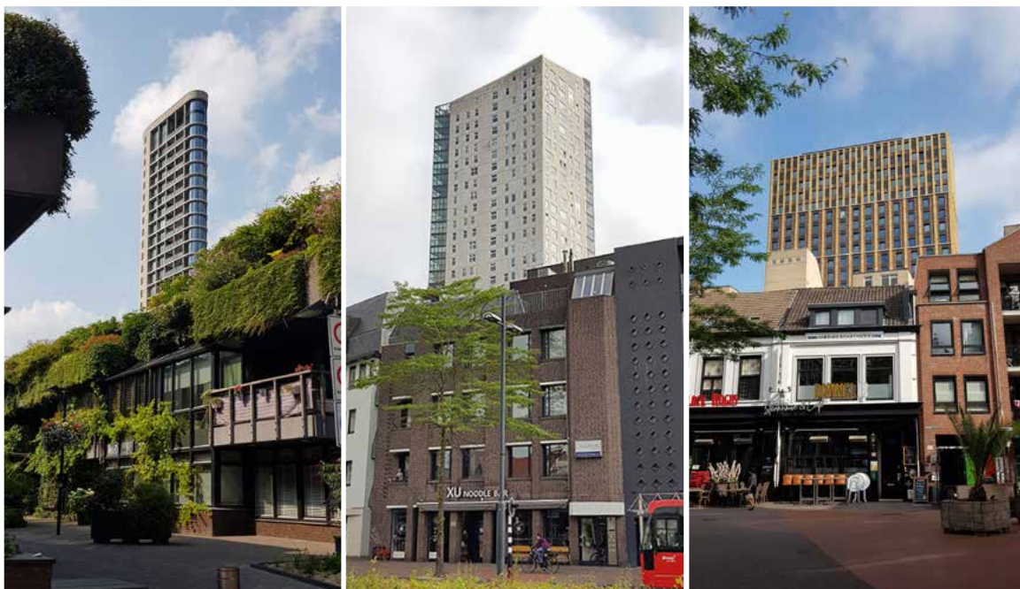
Voorbeelden van Eindhovense laag met op de achtergrond hoogbouw
