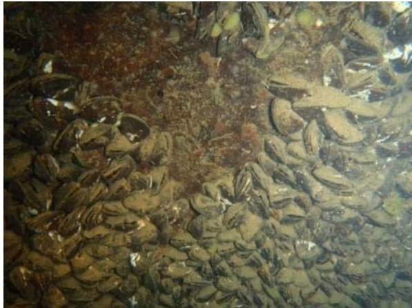
Figuur 5.15: Geen schades betonnen wanden
