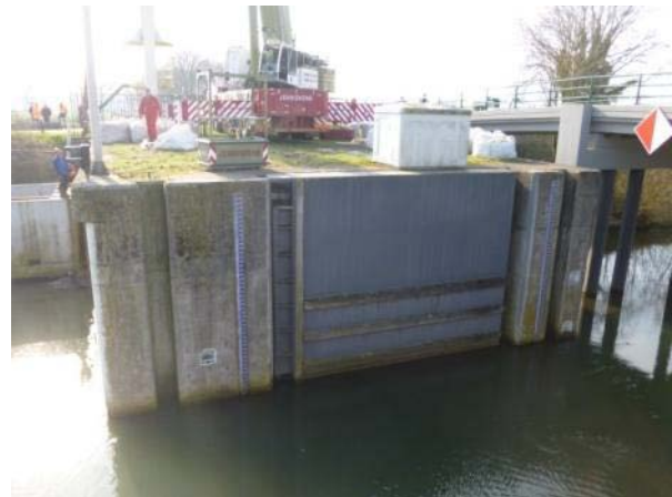
Figuur 4.7: Werkzaamheden in uitvoering
