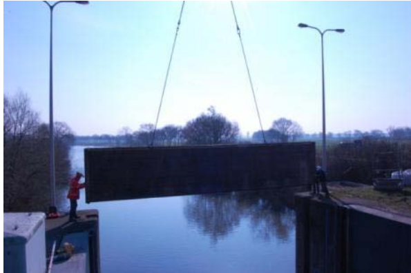
Figuur 4.4: Plaatsen droogzetschot
