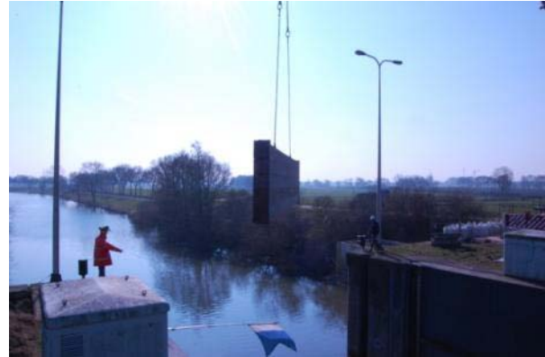
Figuur 4.5: Plaatsing droogzetschot
