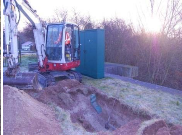
Figuur 4.9: Graafwerkzaamheden voor controle verankering damwand
