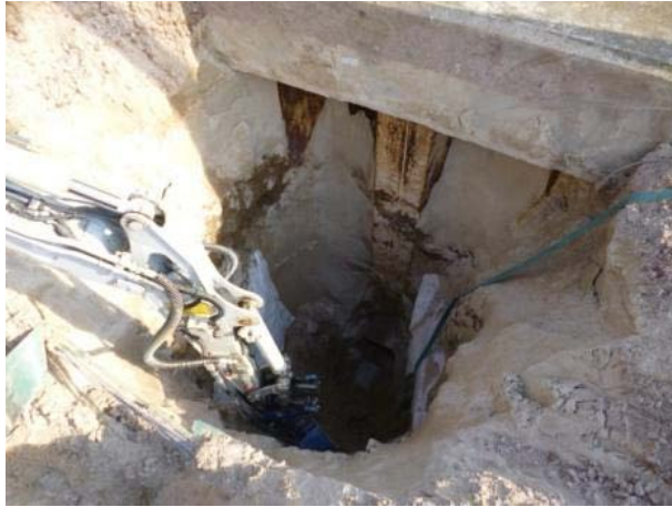
Figuur 4.8: Vrij graven ankerstang en achterzijde damwand
