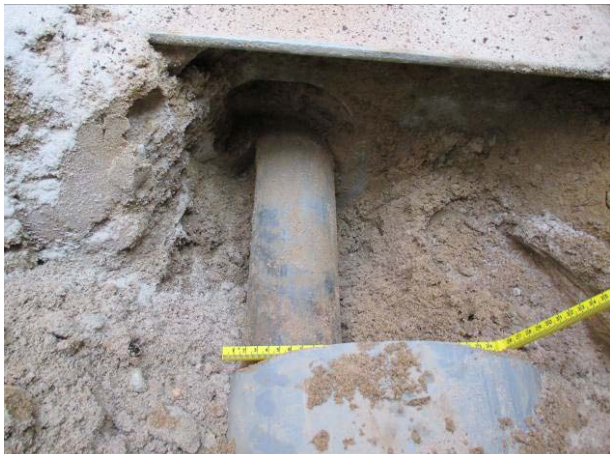
Figuur 4.10: Detail ankerstang
