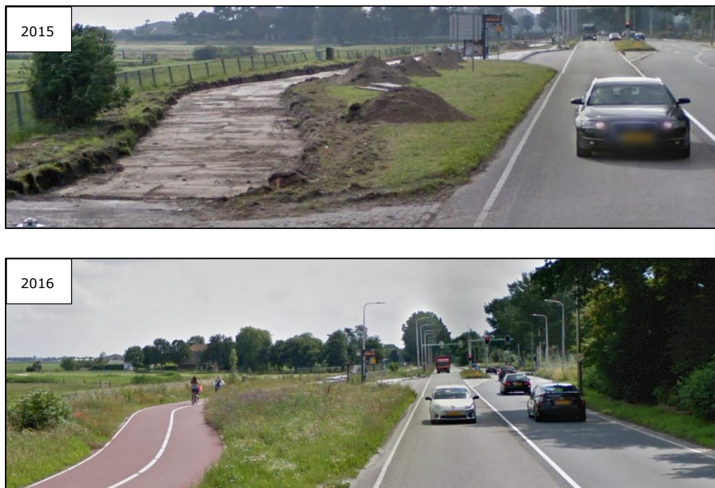
Figuur 4: Aanleg van fietspad ten oosten van Bovenkerkerweg in 2015 (bron: Google Streetview)
