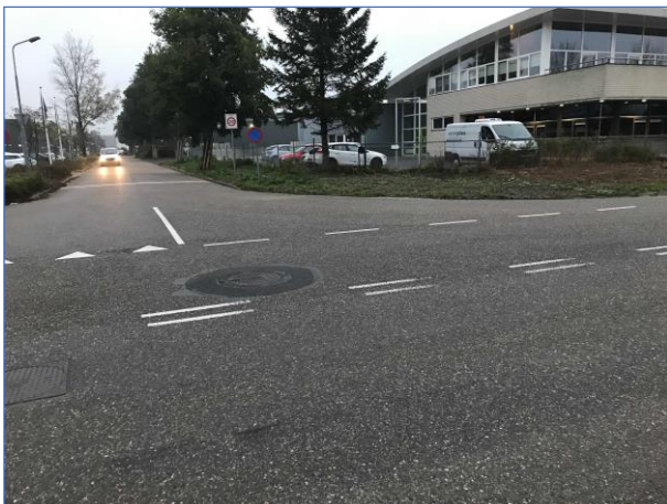
Figuur 6 De Punt kruising lichte en matige rafeling
