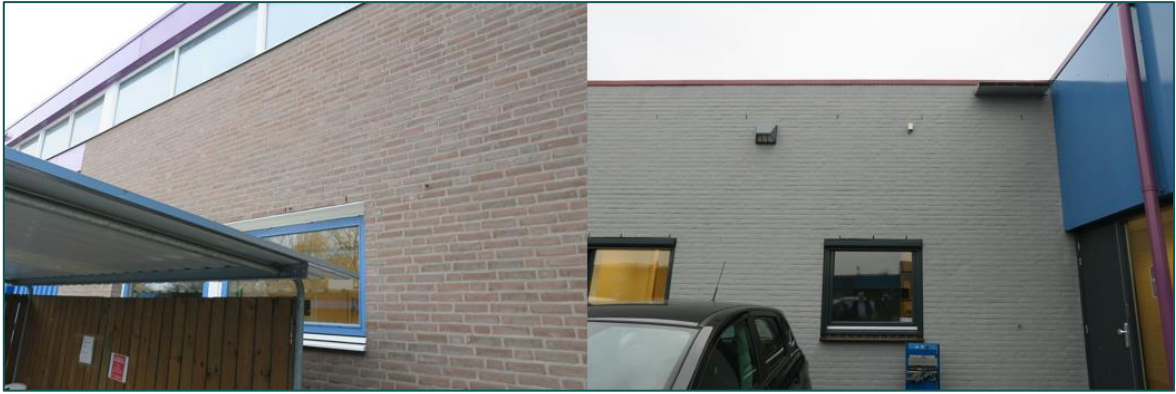
Figuur 3.1 Voor de stootvoegen van een aantal ramen staat een fietsenstalling (links). De overige stootvoegen zijn toegankelijk voor vleermuizen (rechts).
