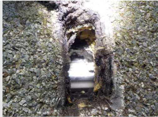
De dakbedekking is tot op de stalen dakplaten geopend, de onderste daklaag is bemonsterd
