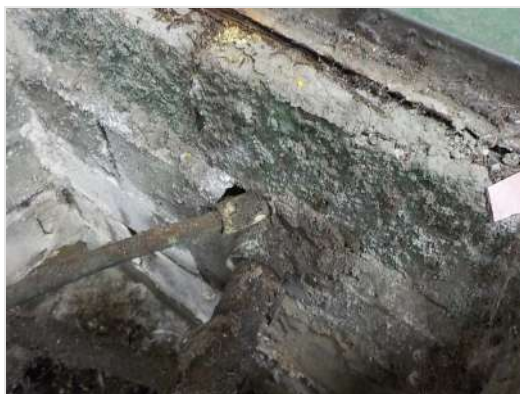
Mantelbuizen/doorvoeren van pvc
