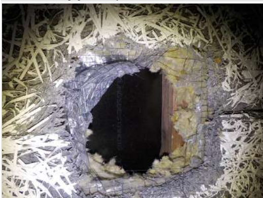
Achter de houtwolcementplaten is geen bron aanwezig
