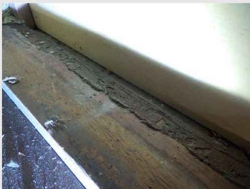
Beglazingskit 1 bij reeds verwijderde en afgetimmerde ramen
