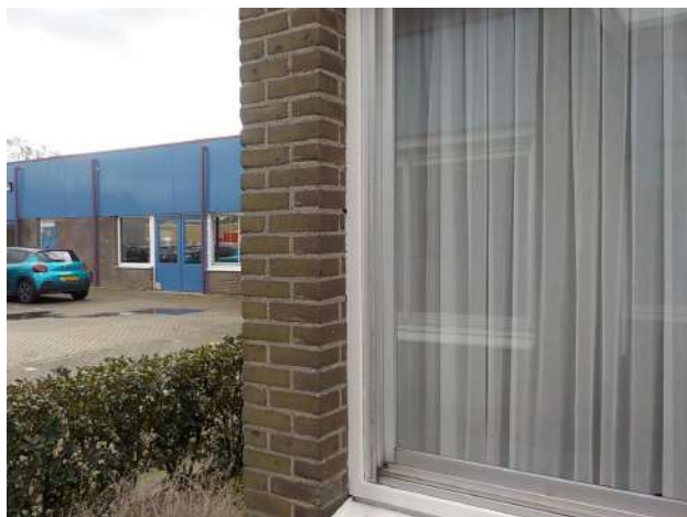
Loderiet in spouw naast kozijn
