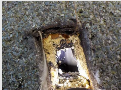
De dakbedekking is tot op de stalen dakplaten geopend, de onderste daklaag is bemonsterd
