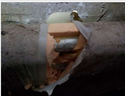
Alle leidingisolatie is onverdacht
