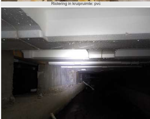
Kruipruimte, geen asbestbronnen
