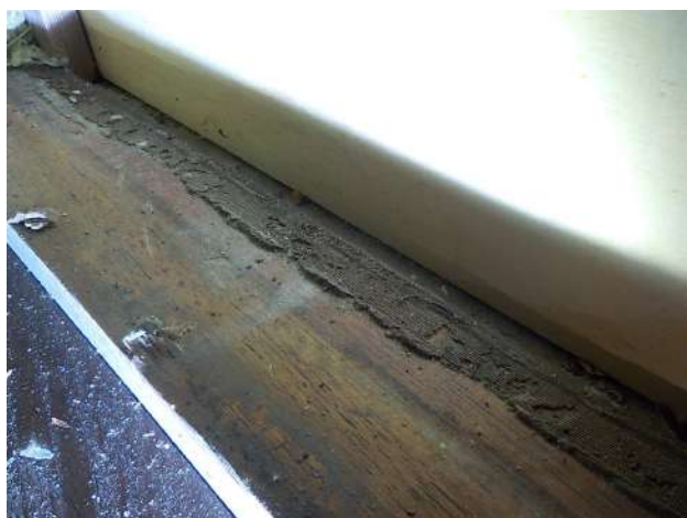
Beglazingskit 1 bij reeds verwijderde en afgetimmerde ramen
