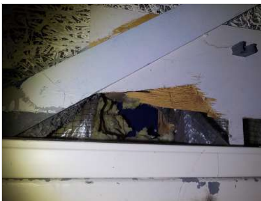
Achter de houtwolcementplaten is geen bron aanwezig
