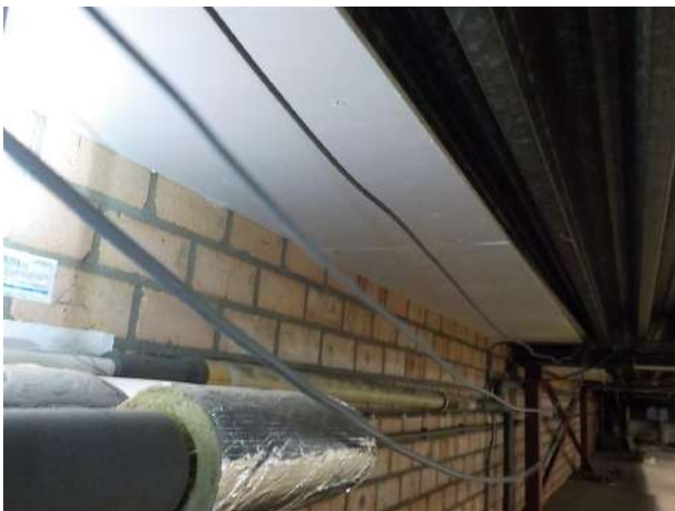
Loopgedeelte boven gang naast magazijnruimte: beplating tegen plafond, naast muur
