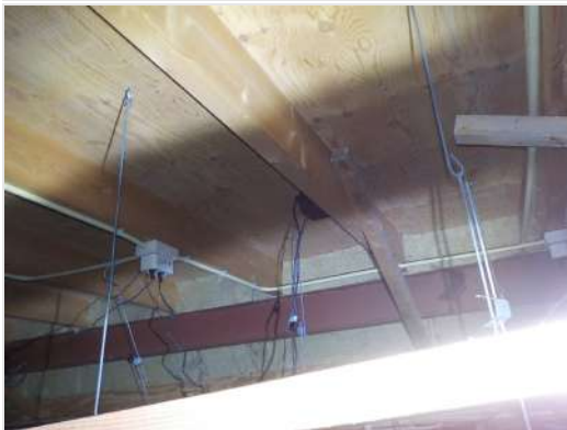
Inspectie boven vaste plafond personeelsentree, geen bronnen
