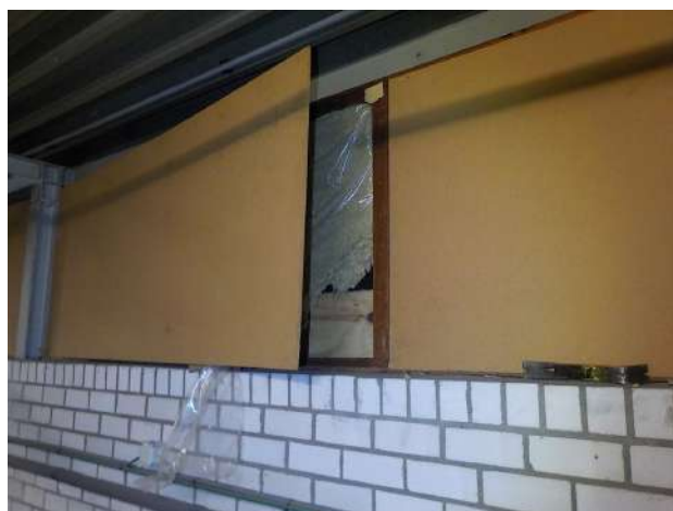
Afgetimmerde ramen op 1e etage
