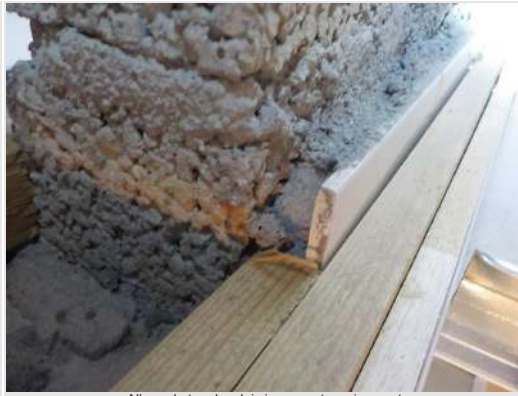
Alle oude tegelwerk is in cementspecie gezet
