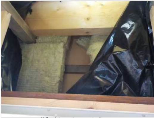
Holle ruimte gevels: geen asbestbronnen
