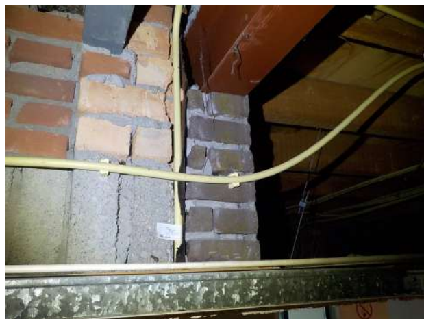
Loderiet in voormalige buitenmuur, nu in pandig (bij personeelsentree)
