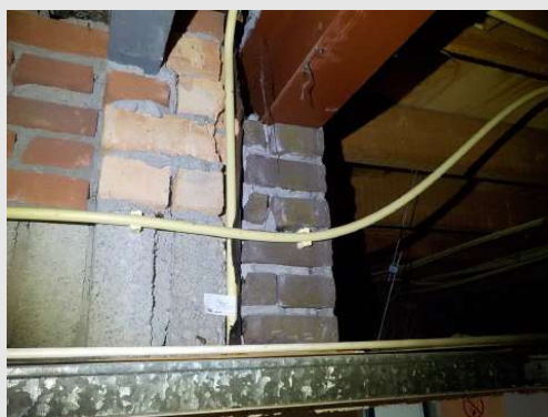
Loderiet in voormalige buitenmuur, nu inwendig (bij personeelsentree)
