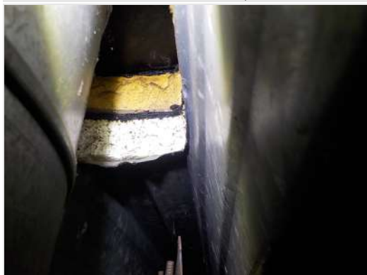
Daklaag: staalplaat/piepschuimislatie 1e dak/schuimislatie 2e dak
