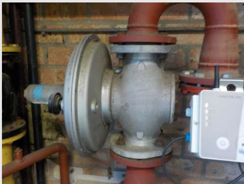
2 asbestpakkingen in de gasdrukklep
