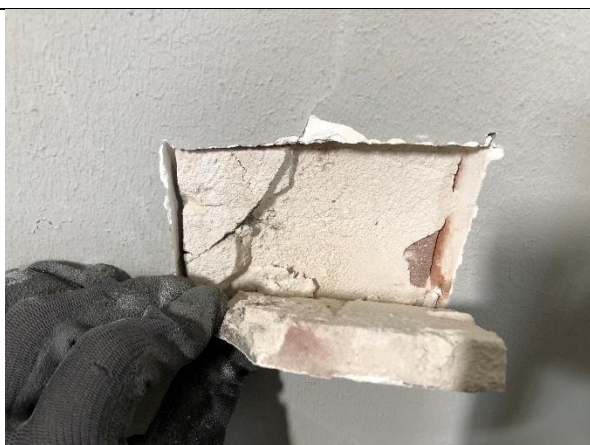
38. Onthechting stucmortel vanaf het oppervlak van de vertinlaag. De achterzijde van de losgeraakte stucmortel geeft sterk wit af (krijtend).
