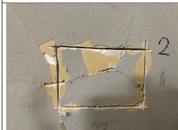
41. Onderzoeklocatie 2 (linker wand zijde altaar).
