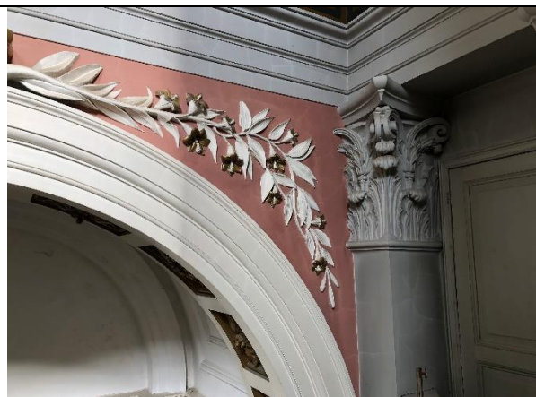
19. Orgelplatform. Aan de rechterzijbeuk werd geconstateerd dat ook achter het sierende takmotief er holklinkend stucwerk voorkomt.
